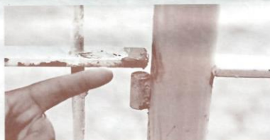
GRADE LATERAL DA CETURB - GV. SERRADA. (DEVIDO A PIQUETE). PARA PERMITIR O ACESSO DA DIRETORIA ÀS INSTALAÇÕES DA EMPRESA.
