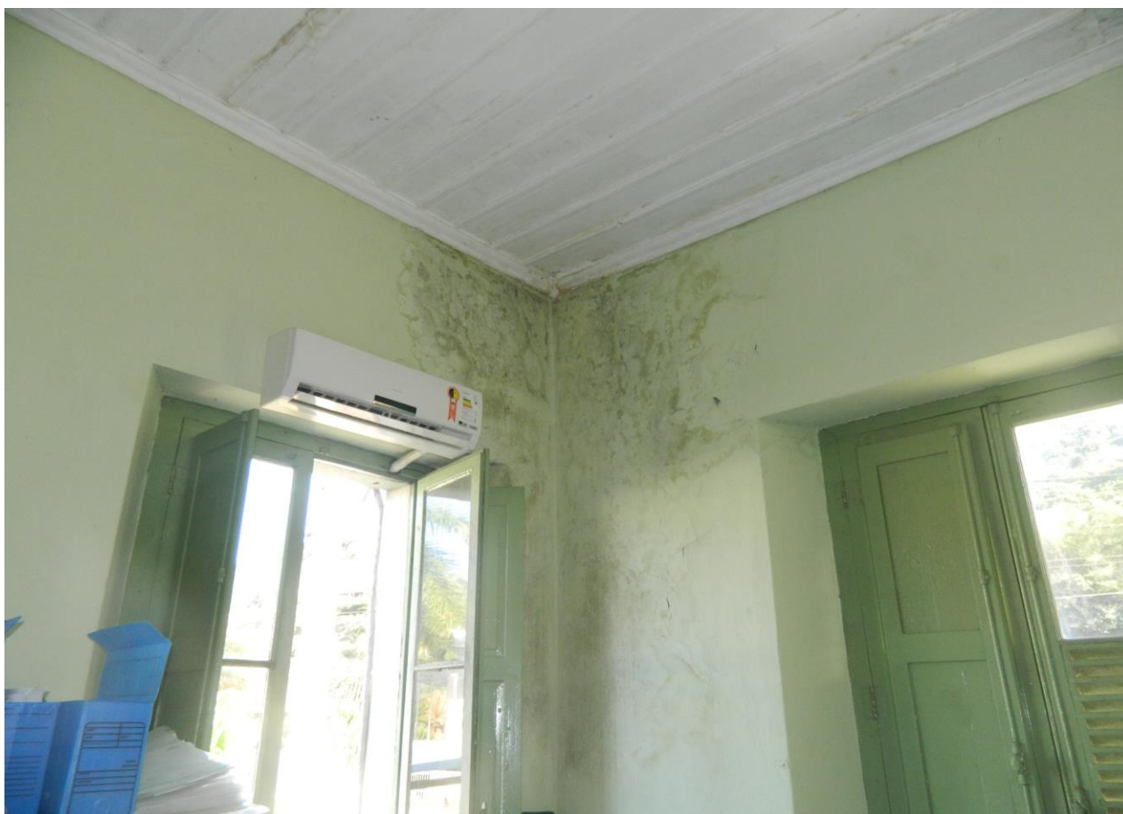
Foto 02- salas com infiltrações, no IDAF e no INCAPER.
