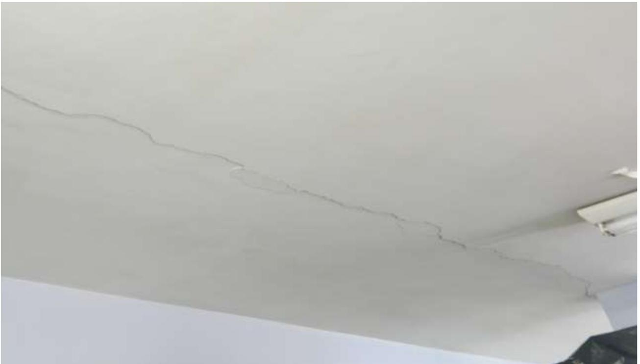
**Foto 02** - rachaduras, descascaduras em todo teto da sala de discoteca.
