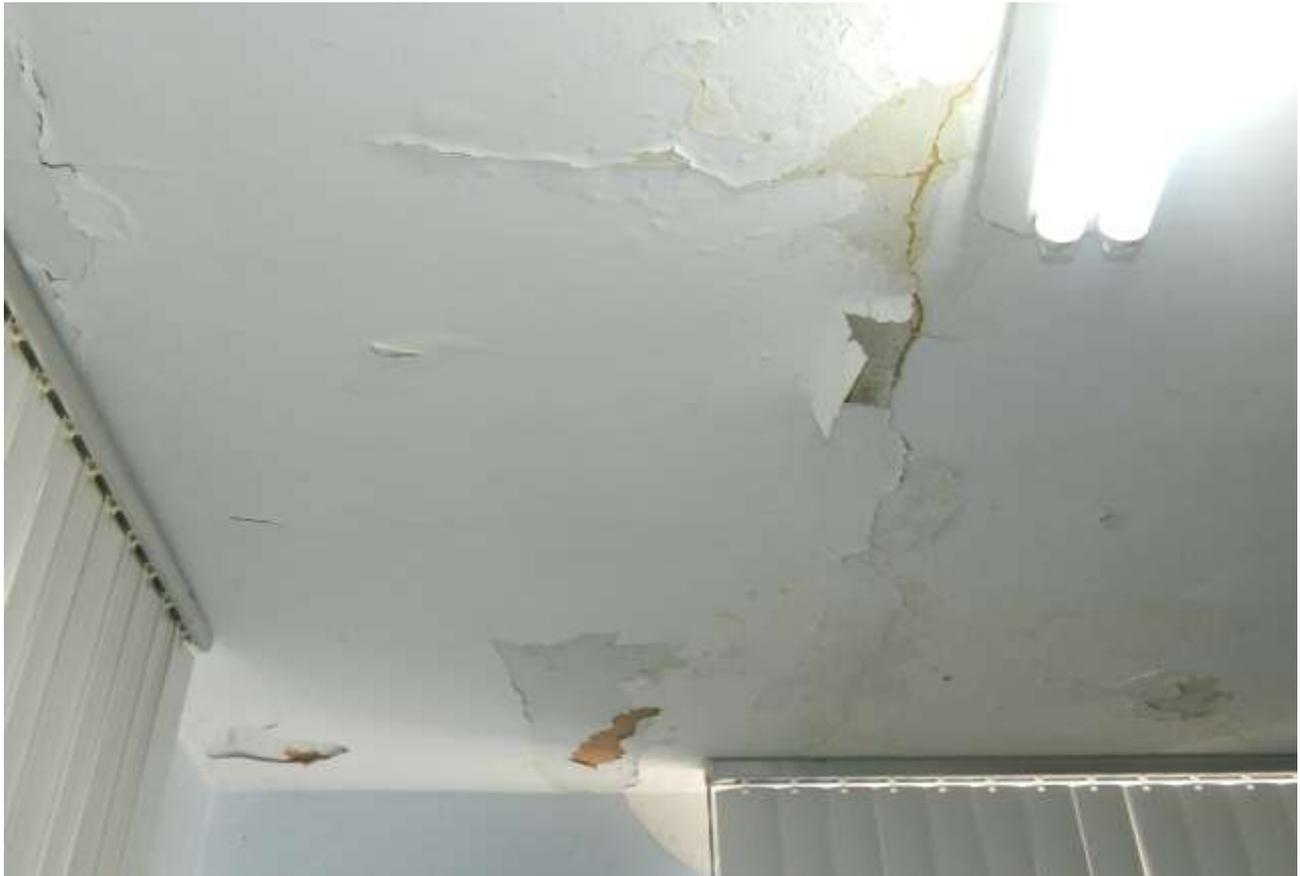
**Foto 01** – rachaduras, descascaduras em todo teto da sala de discoteca.
