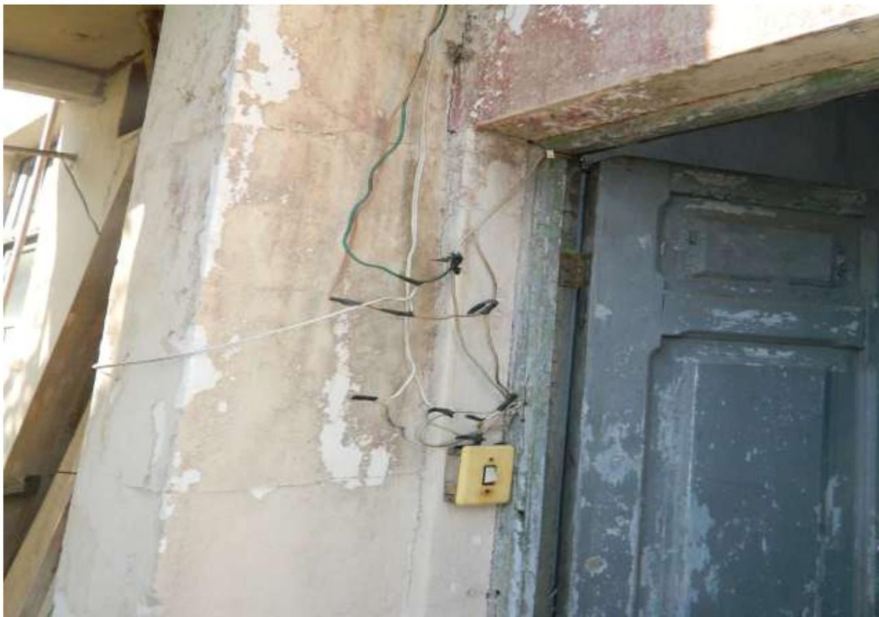
**Foto 13** – sala de descanso de serviços gerais (instalação inadequada).
