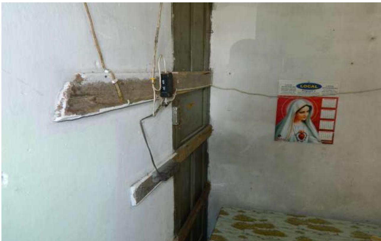
**Foto 15** – instalação inadequada na sala de serviços gerais.
