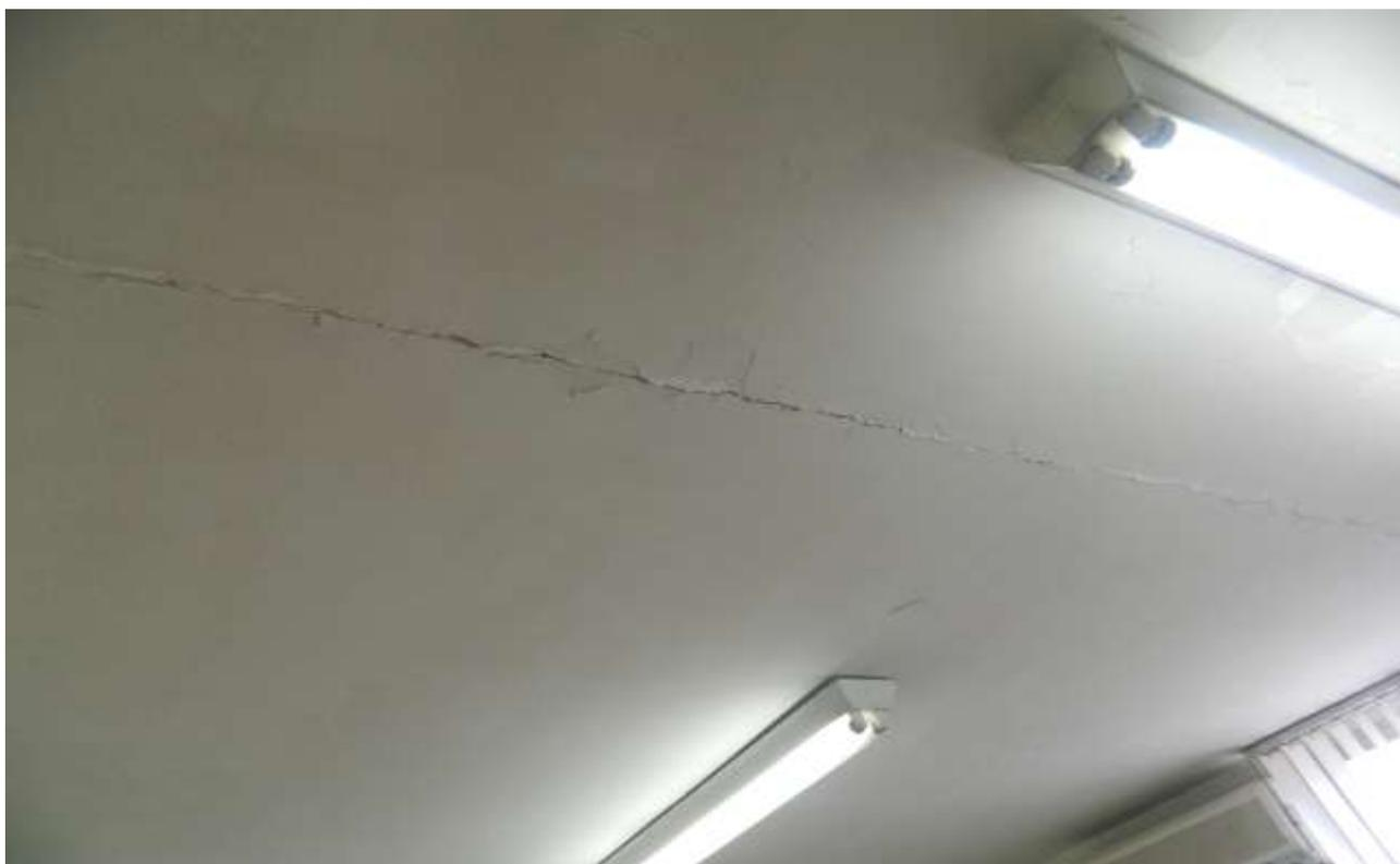
**Foto 05** - rachaduras, descascaduras em todo teto da sala de protocolo.
