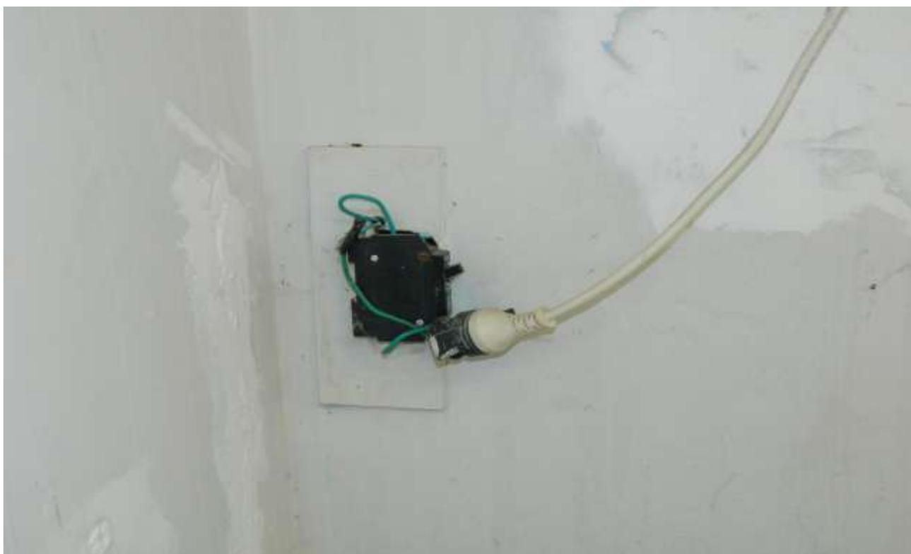
**Foto 14** – instalação inadequada na sala de protocolo.
