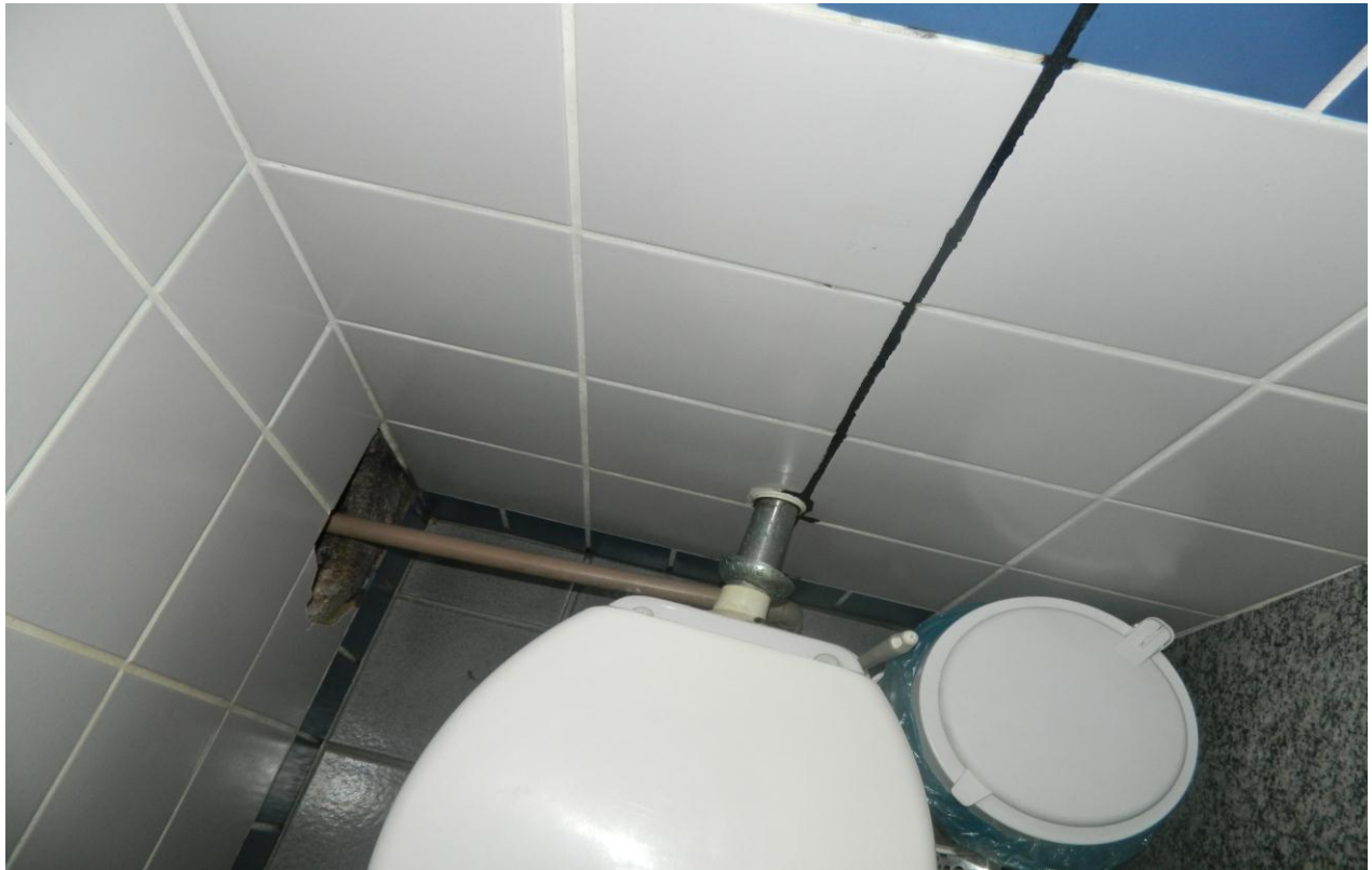
Foto 07 – infiltrações nas paredes perto do vaso sanitário no 11º andar.
