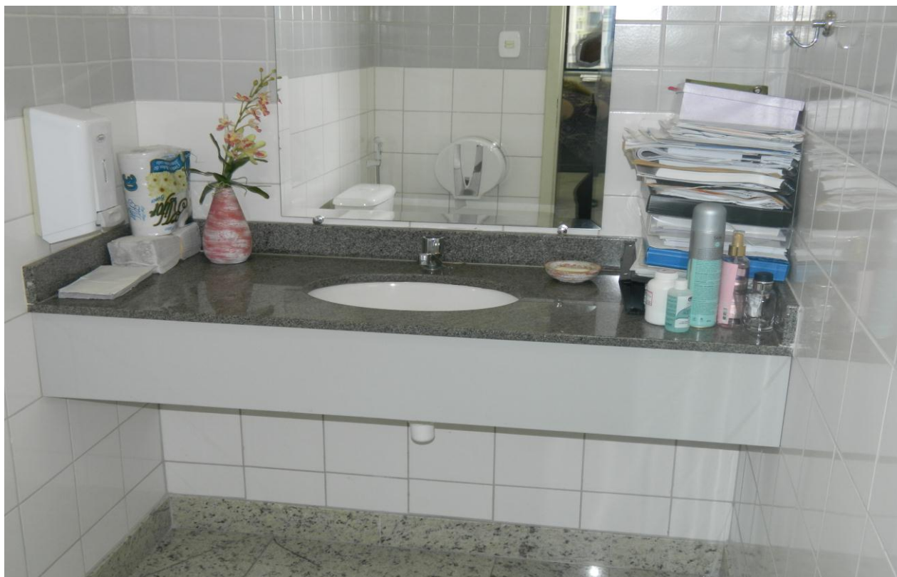
Foto 10 – documentos arquivados no banheiro da subsecretaria de mobilidade urbana no 11º andar.
