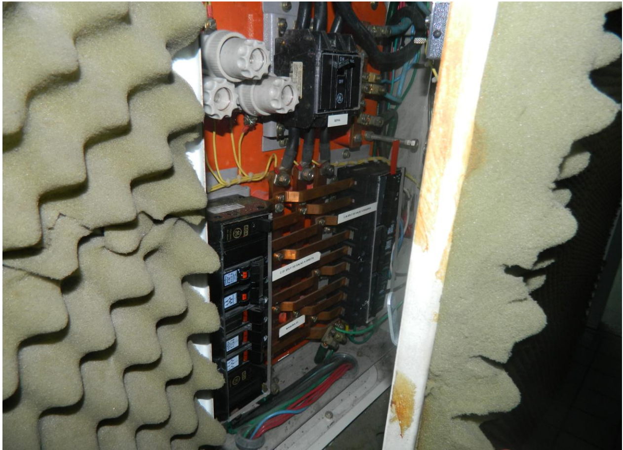
Foto 13 – caixa disjuntor totalmente aberta no 11º andar.
