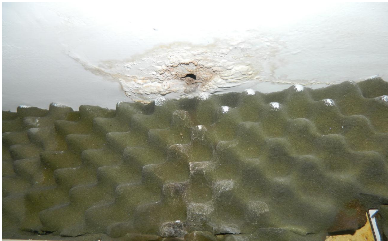
Foto 11- infiltração no teto perto da caixa de derivação elétrica no 11º andar.
