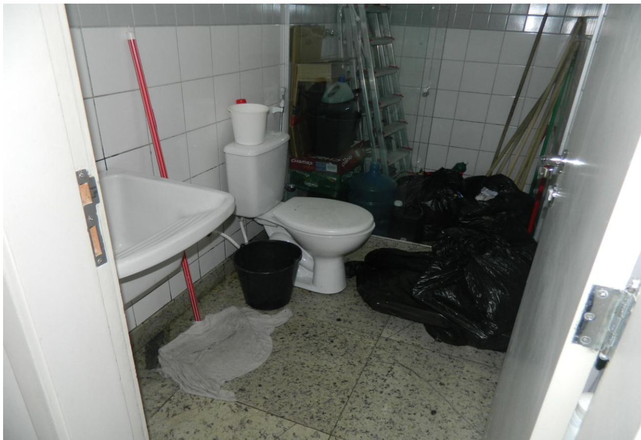
Foto 05 – depósito de lixo e vários materiais no banheiro do 6º andar.
