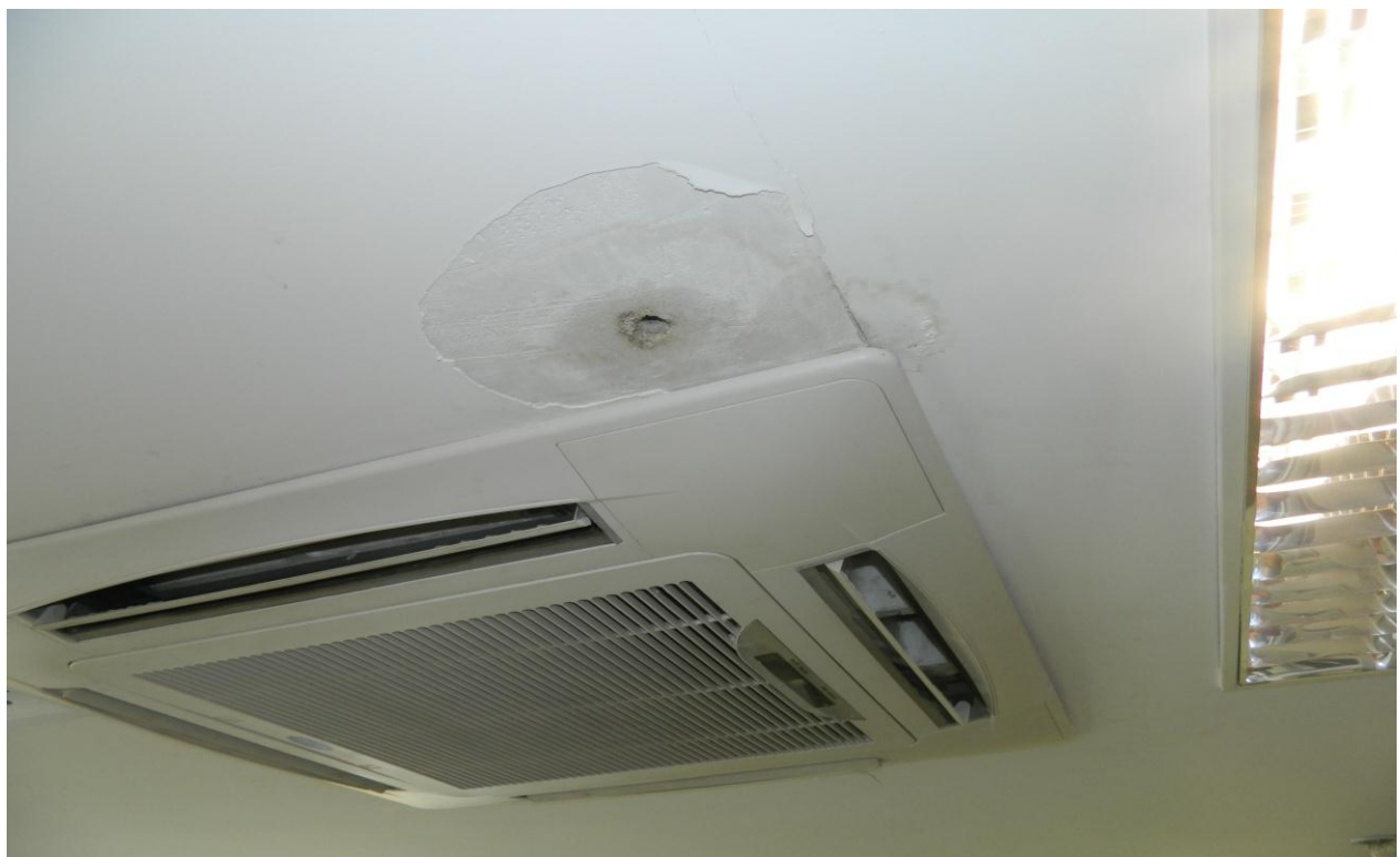
Foto 04 – infiltração ao lado do ar condicionado de teto no 11º andar.
