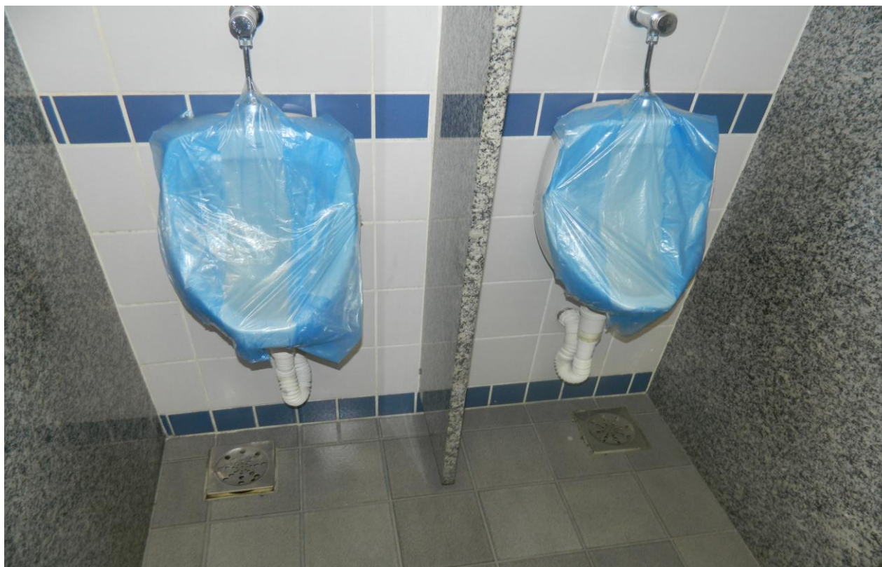
Foto 06 – mictórios danificados no 11º andar.
