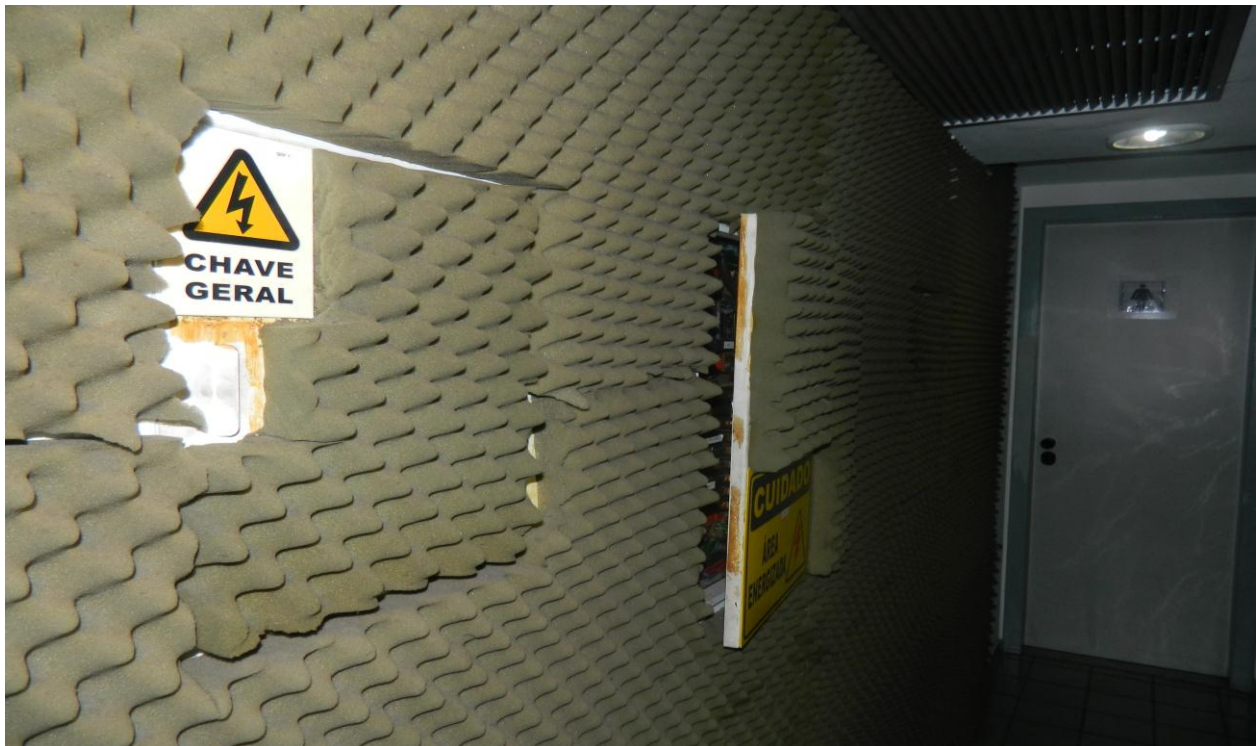
Foto 14 – corredor revestido de material totalmente inflamável no 11º andar.
