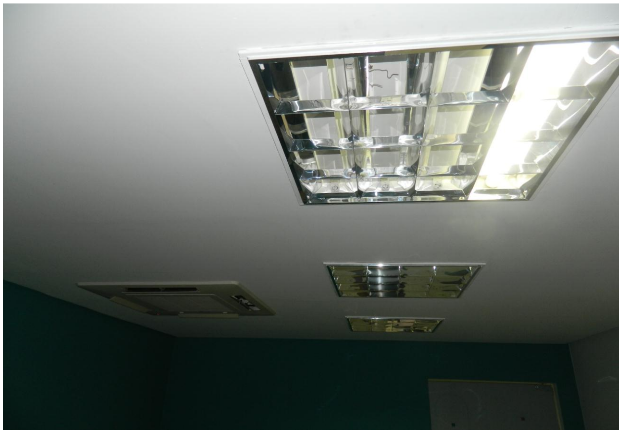
Foto 01 – baixa luminosidade na recepção.
