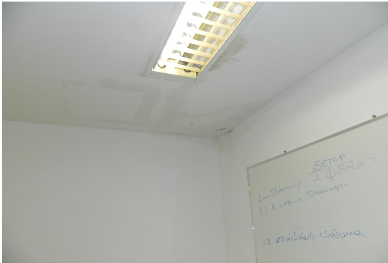
Foto 03 – infiltração no auditório no 11º andar.
