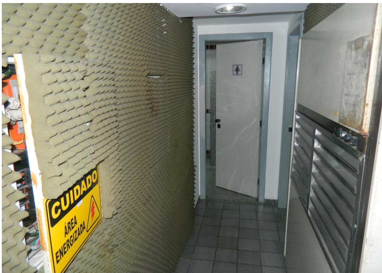
Foto 12 – caixa energizada totalmente aberta em local de passagem de servidores.
