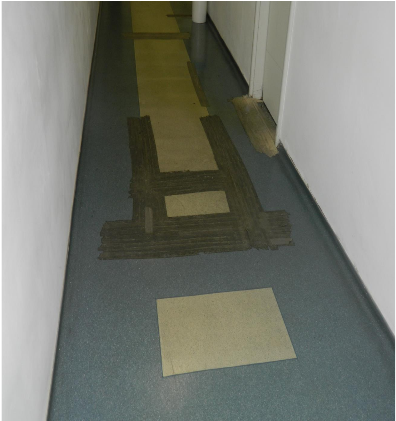
Foto 10 - desprendimento de piso no corredor da copa.
