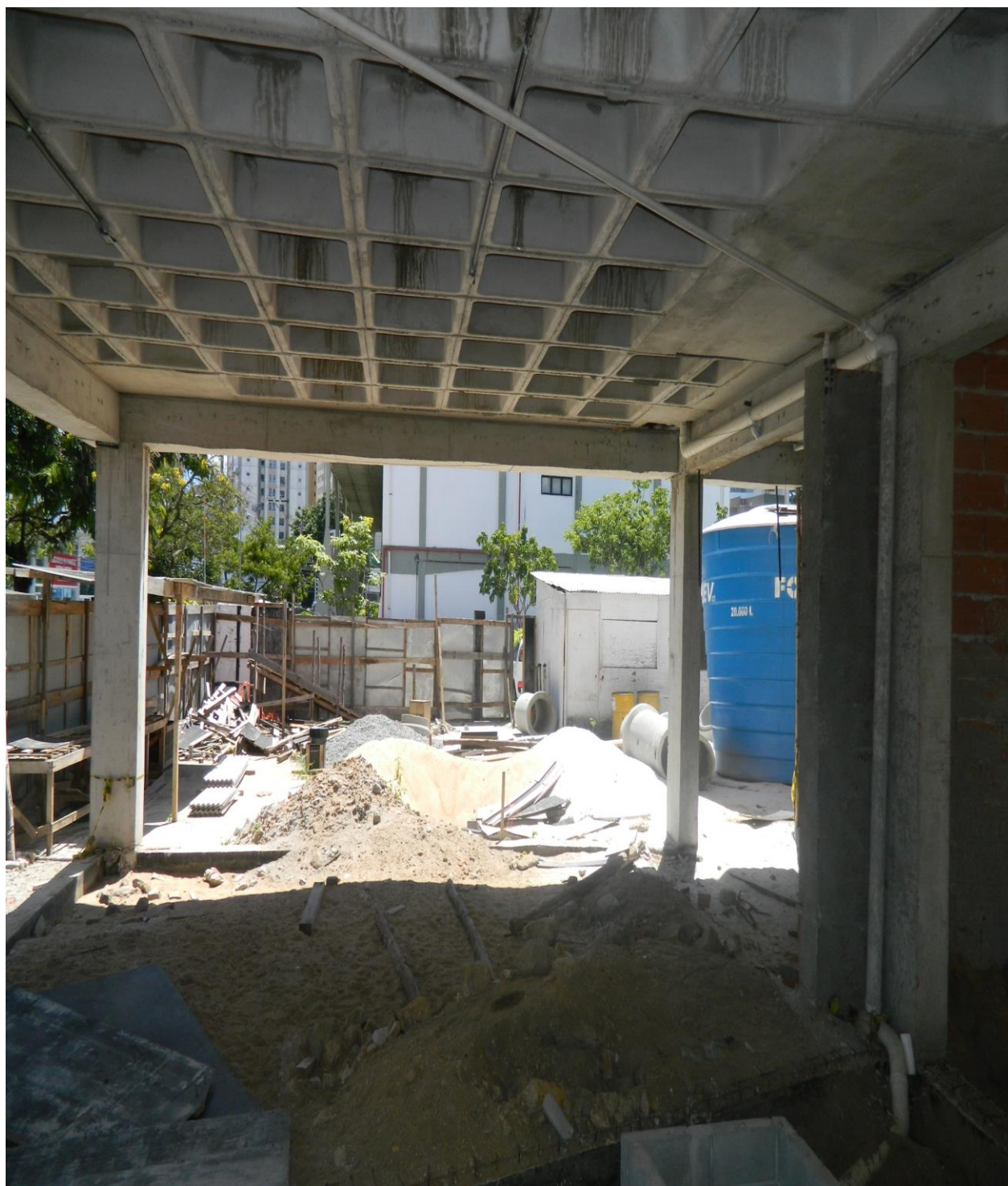
Foto 11- obras de expansão paradas.
