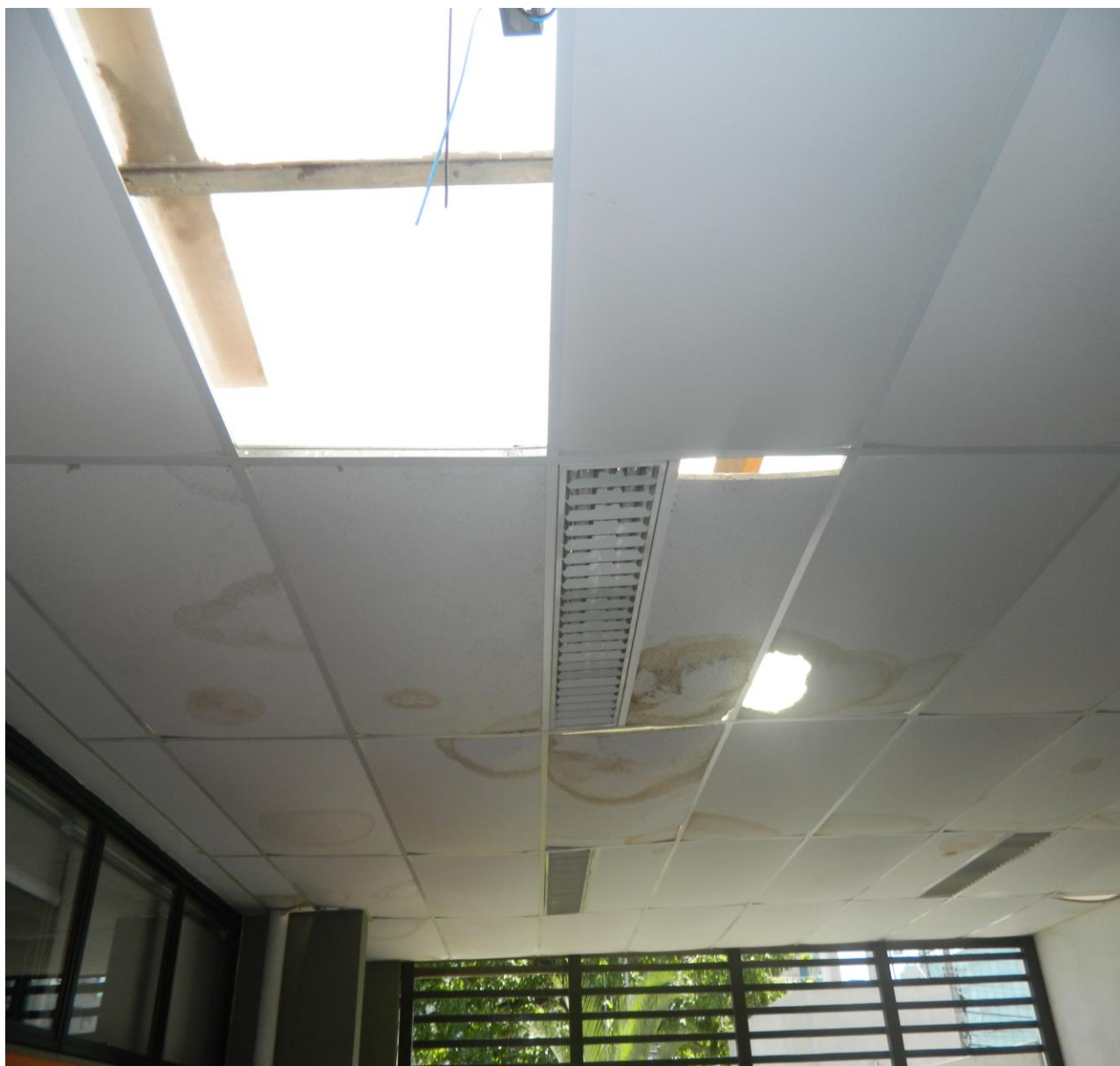
Foto 01 – forro caindo, muito calor no refeitório.
