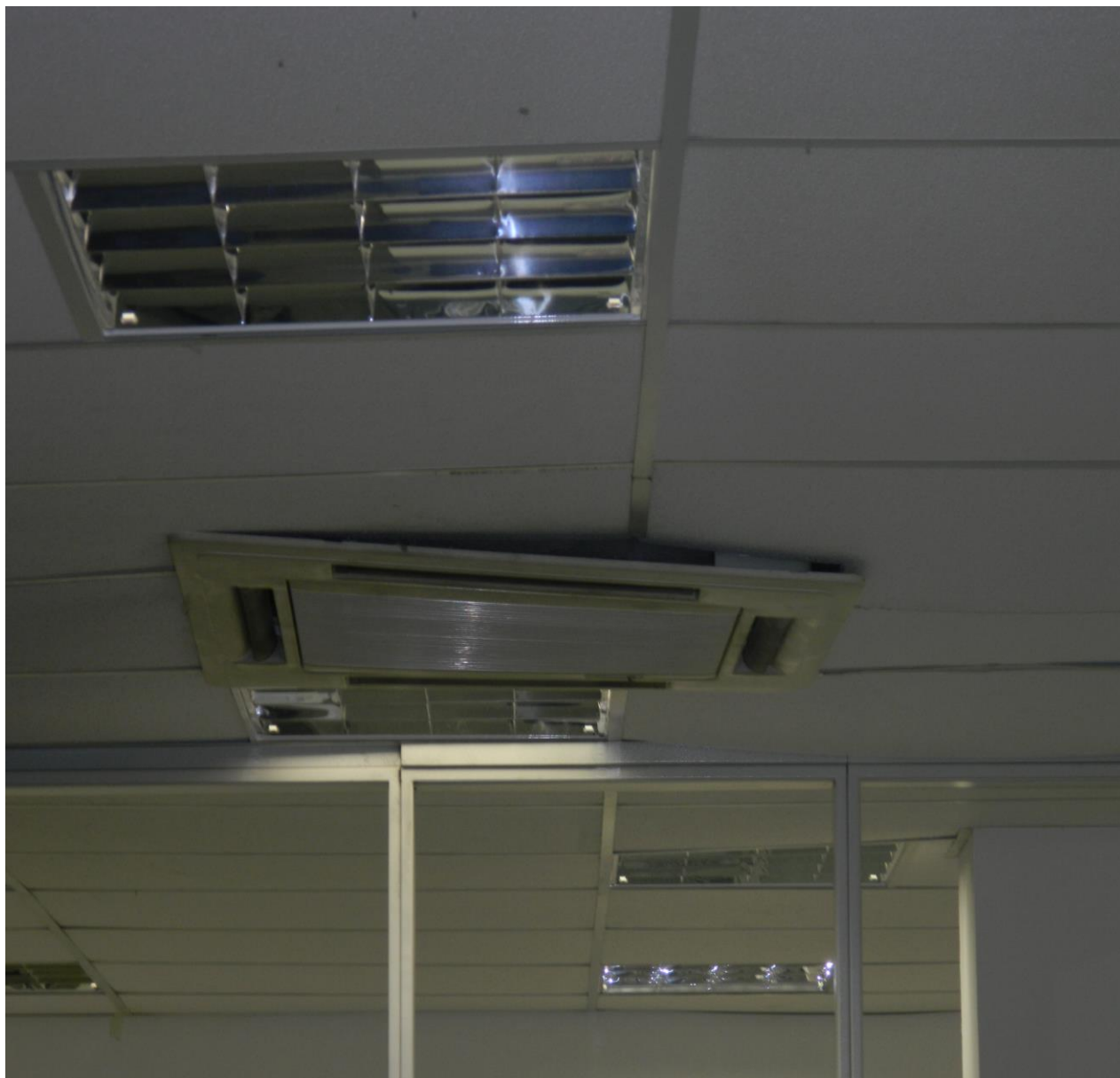
Foto 06 – infiltrações afetam o bom funcionamento do ar condicionado na sala de assessoria.
