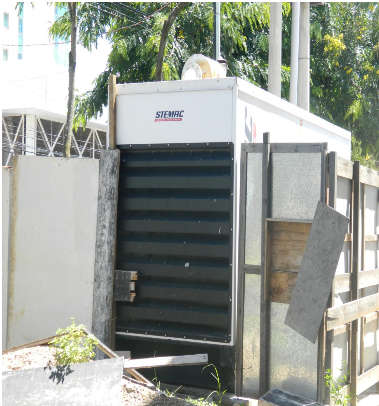
Foto 12 – máquina nova de geração de energia parada.
