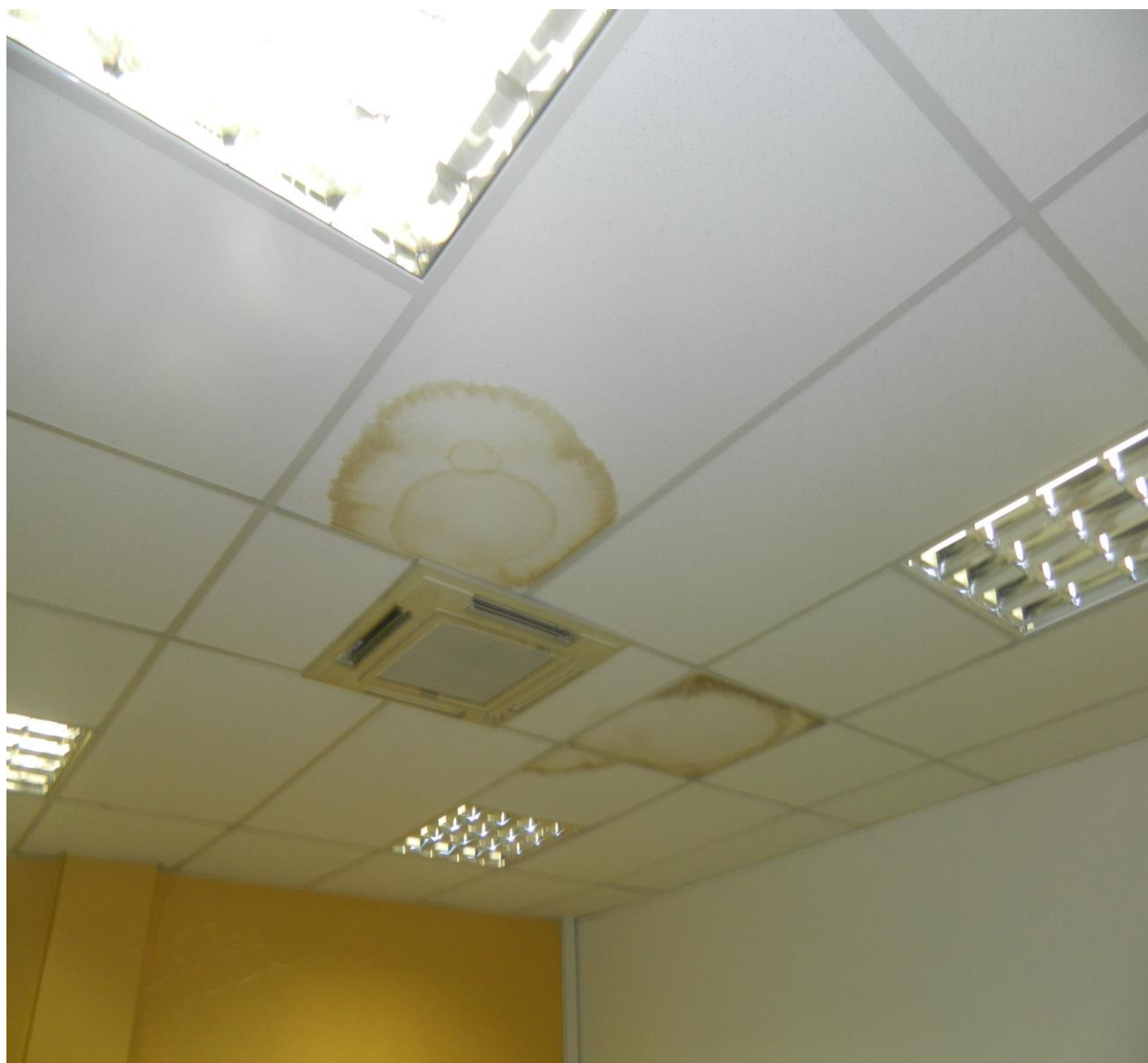
Foto 08 – conserto de todo telhado.
