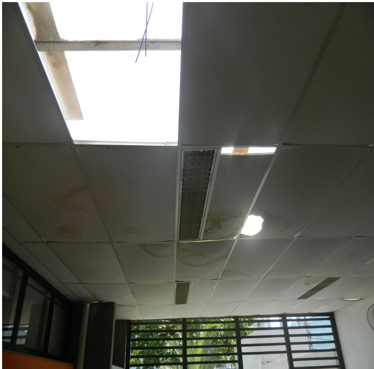
Foto 02 – o telhado do refeitório transmite radiação não ionizante do sol.
