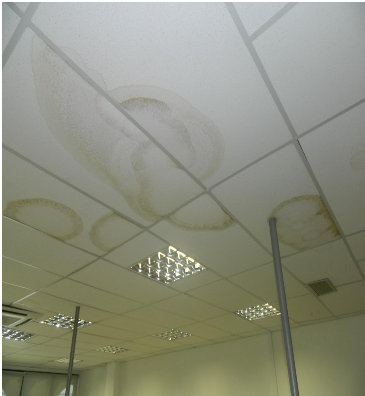
Foto 07 – marcas de infiltrações na sala do GPGF.
