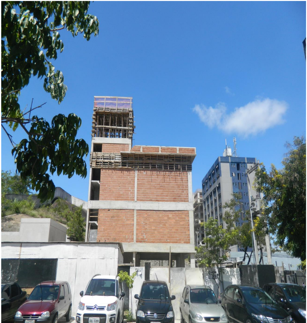
Foto 13 – obra de ampliação inacabada.
