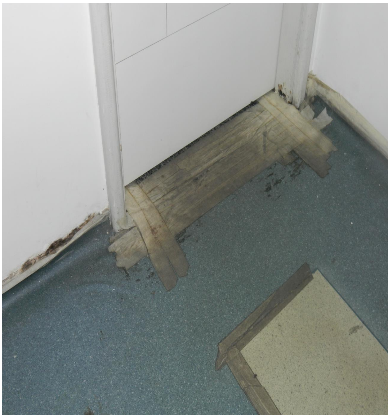
Foto 09 – desprendimento de piso no corredor da copa.
