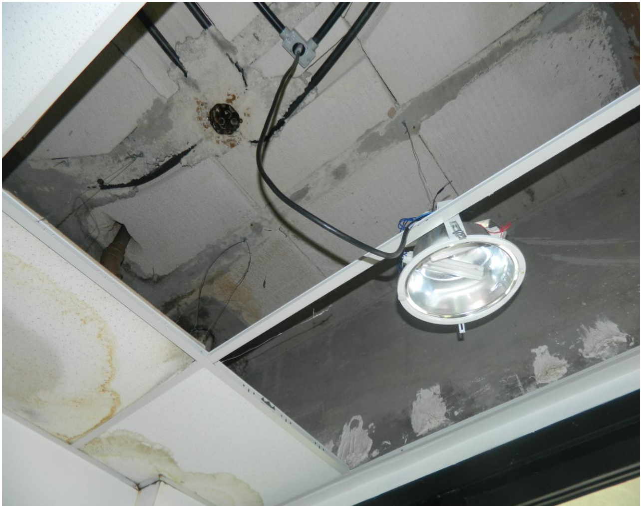
Foto 05 – infiltrações no teto em toda edificação.
