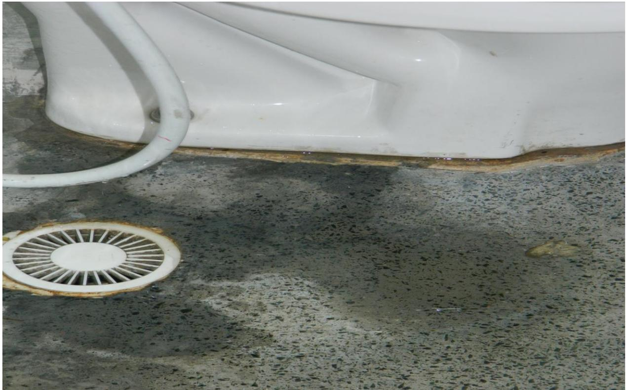
**Foto 03** – vazamento no vaso sanitário do banheiro do laboratório metrológico de massas.
