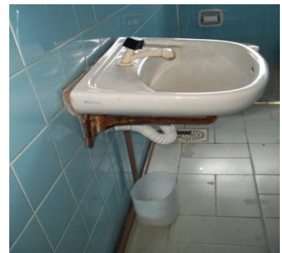
Lavatório Prédio Antigo Servidores
