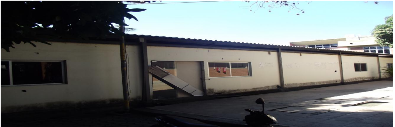
Galpão abandonado depósito de ratos, baratas e mosquitos
