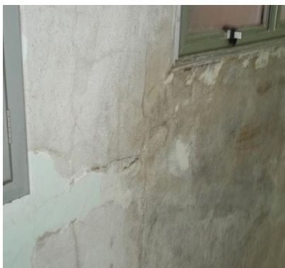
Parede Corredor da C. de Atendimento
