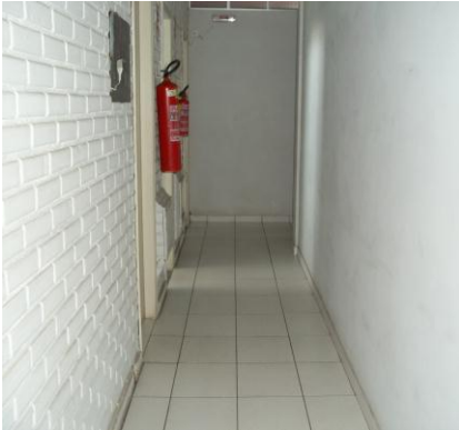
Extintores sem sinalização
