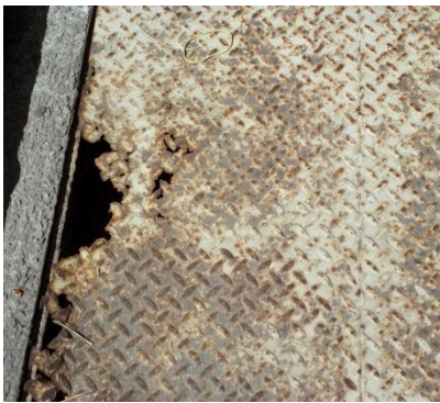
Tampa de Esgoto
