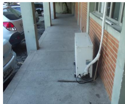
Bebedouro Quebrado Central de Atendimento
