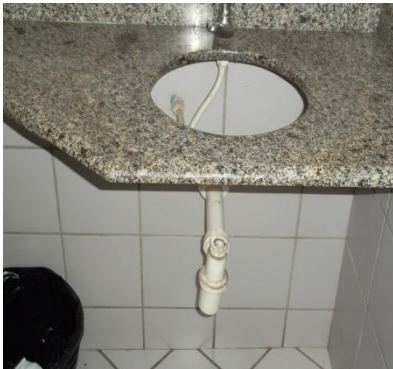
Banheiro (F) Central Atendimento
