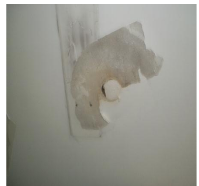
Teto Tele Atendimento Telefônico
