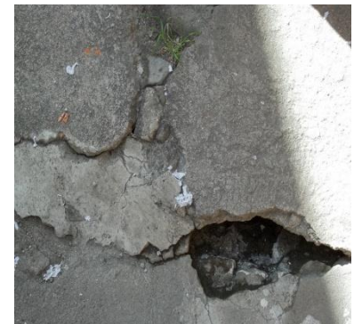
Buraco na Fundação
