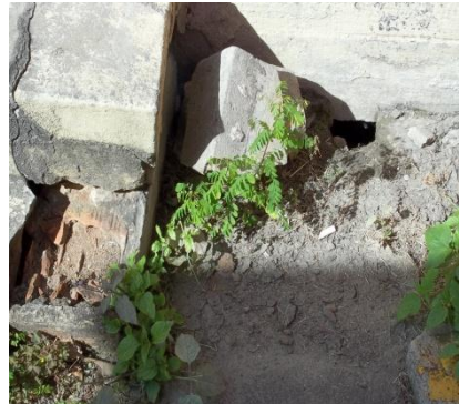
Buraco na Fundação
