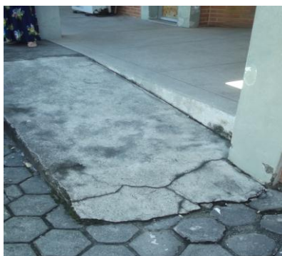
Rampa Acessibilidade Central de Atendimento
