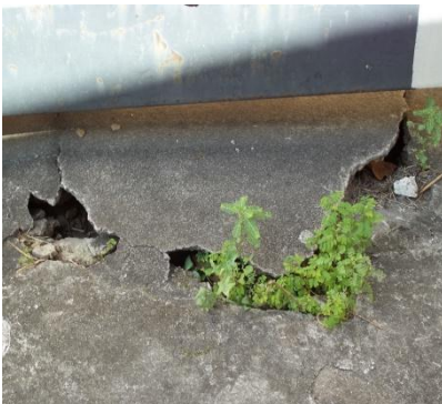
Buraco na Fundação
