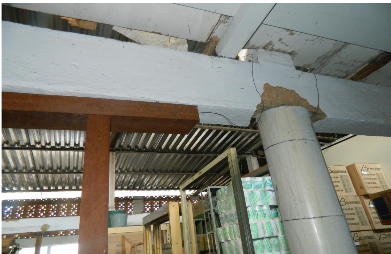
Foto 01 – pilares escorados por caibros.
