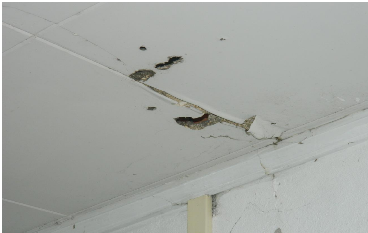
Foto 03 – infiltração no almoxarifado.
