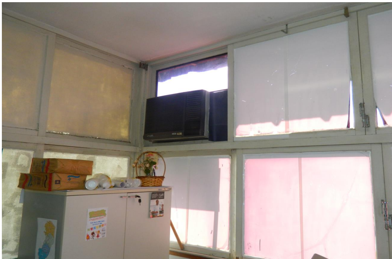
Foto 12 – excesso de luz solar, barulho de ar condicionado e muito calor na sala da assistente social, entre outras salas.
