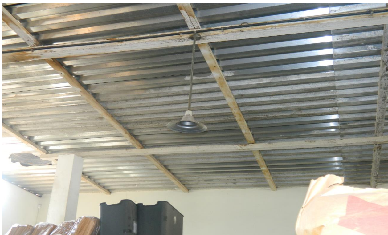
Foto 05 – galpão do almoxarifado sem lâmpadas.
