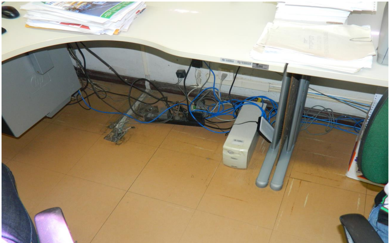
Foto 06 – exposição de fios no almoxarifado.
