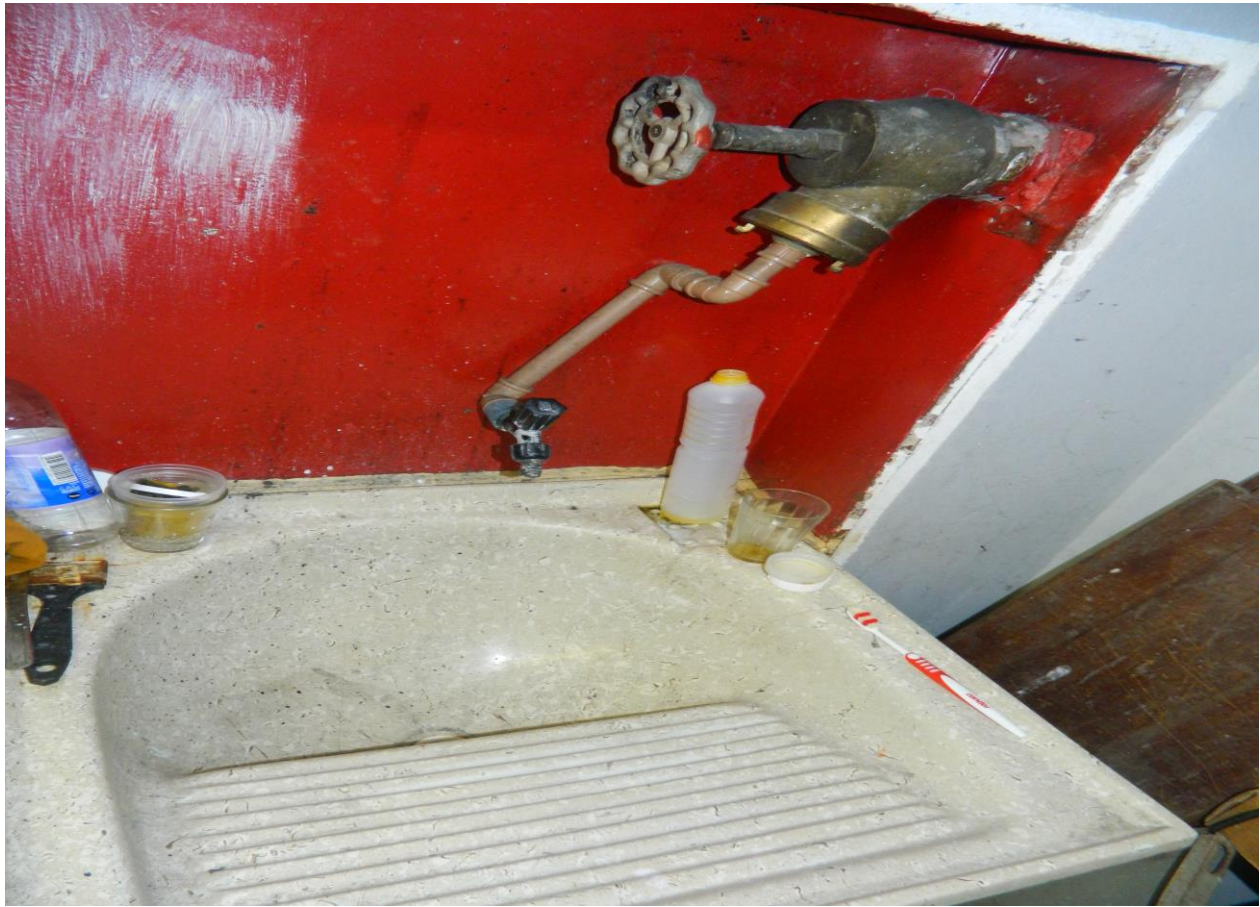
Foto 08 – hidrante servindo de tanque para lavar copos, escovar dentes, na sala de manutenção eletro eletrônica.
