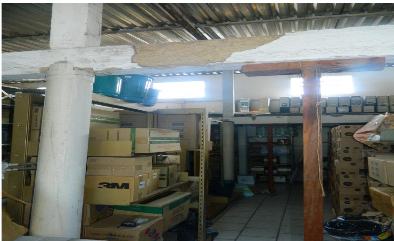
Foto 02 – pilares rachados, no almoxarifado.
