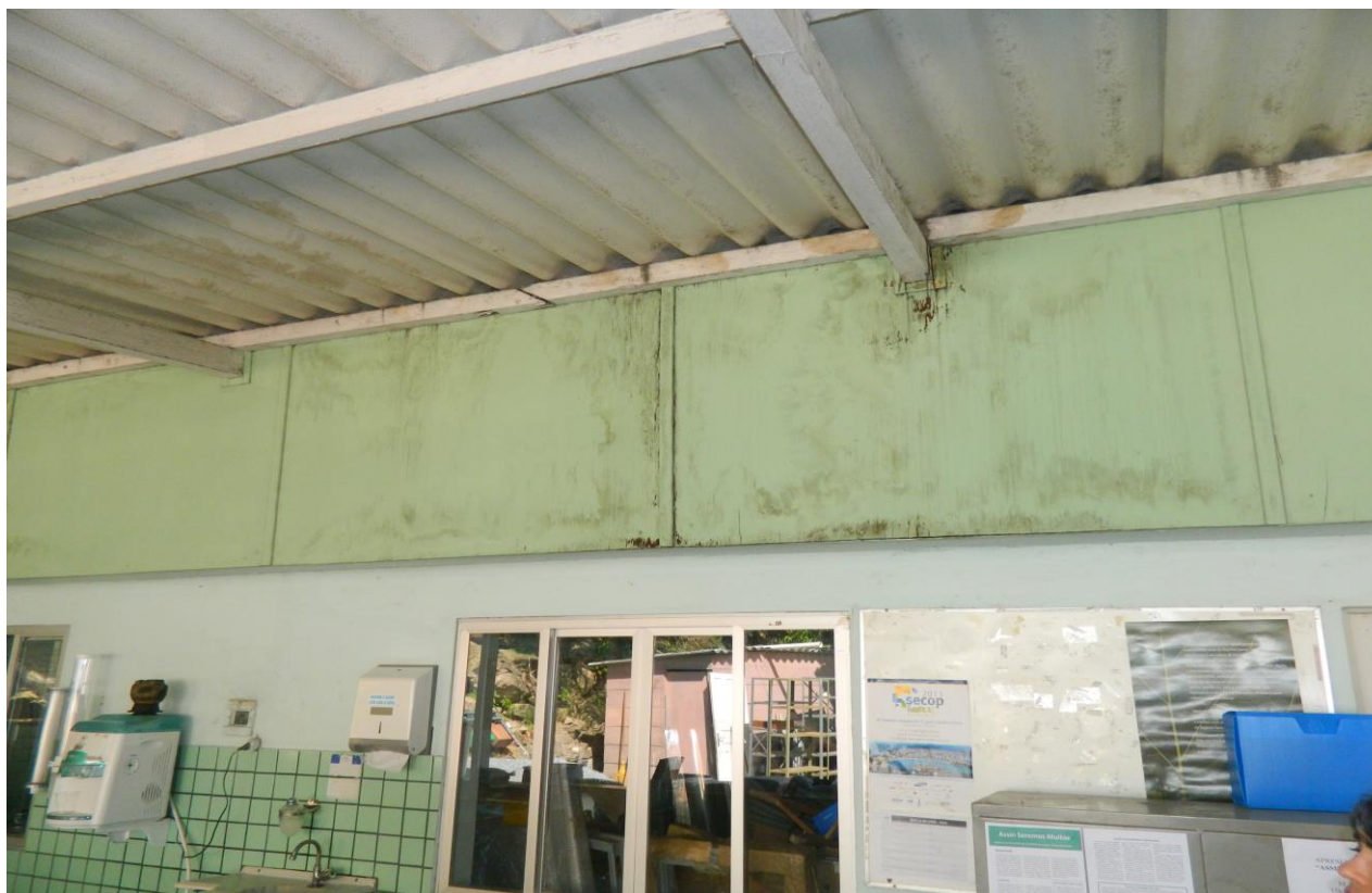
Foto 04 – infiltração no refeitório e salão de jogos, anexo ao almoxarifado.
