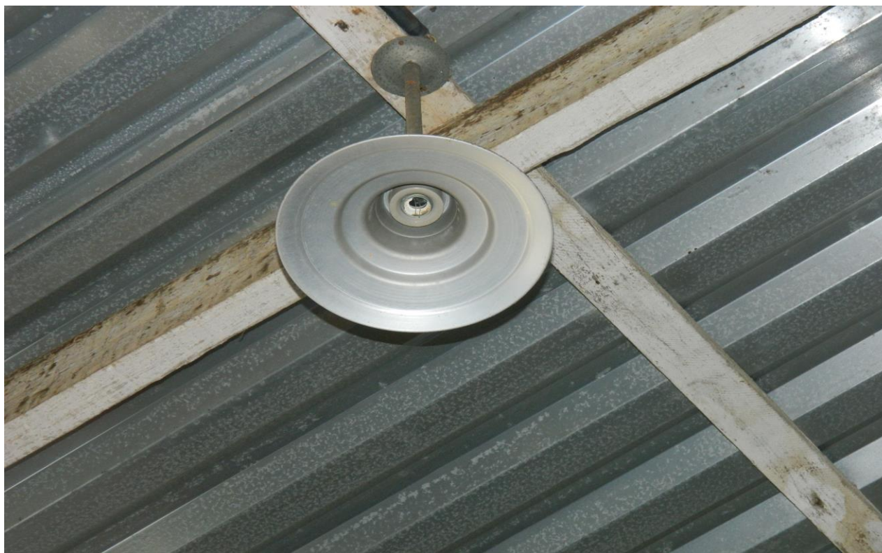
Foto 13 – falta de iluminação artificial em todo almoxarifado.
