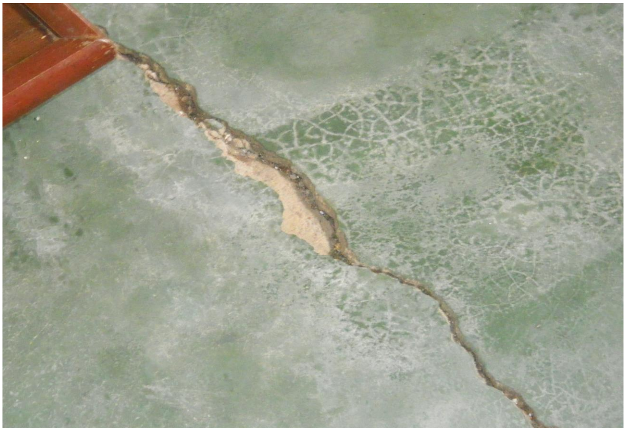
Foto 11- rachadura no chão da moradia.
