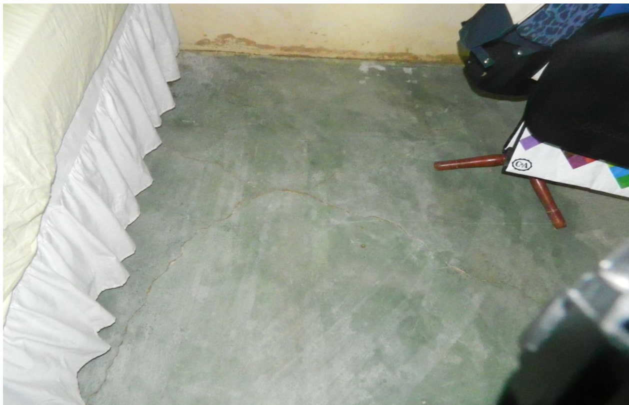
Foto 12- chão de moradia cedendo.
