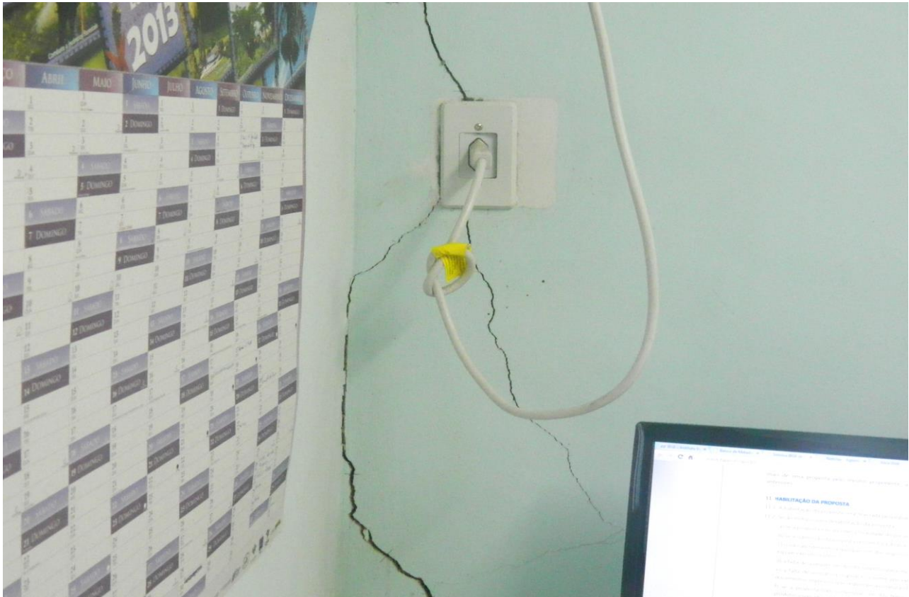
Foto 04- rachadura no administrativo.
