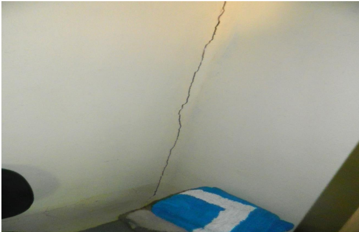
Foto 09 – rachadura nas moradias.
