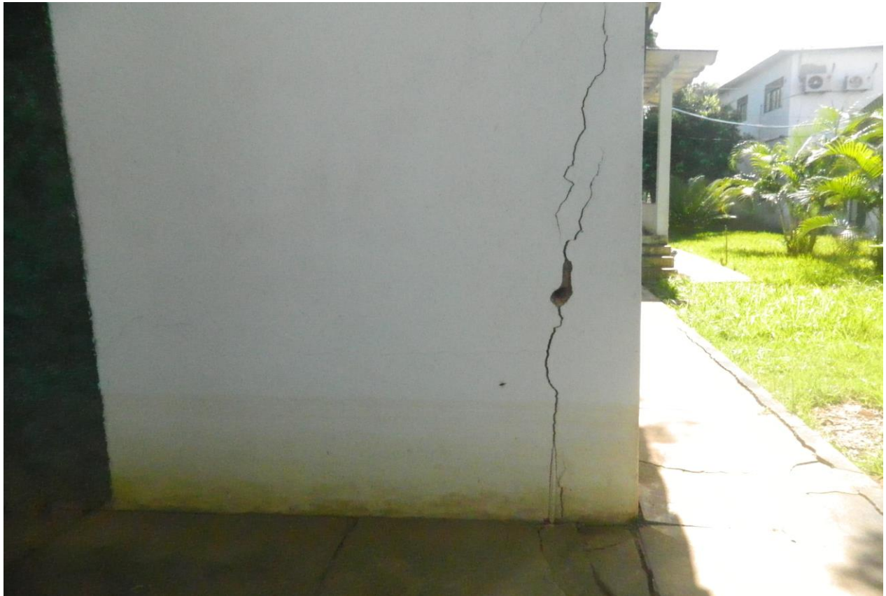
Foto 05 – rachaduras do lado de fora do administrativo.
