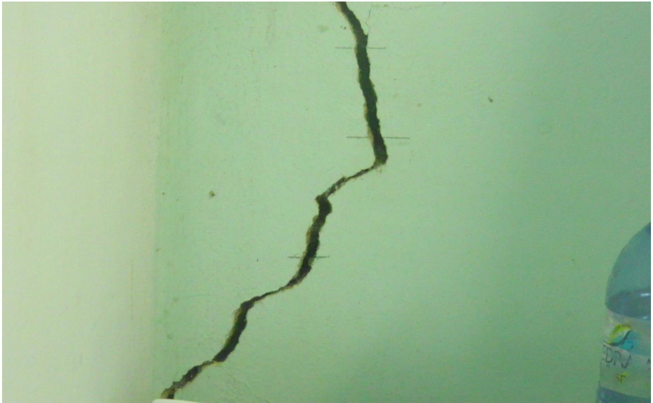
Foto 03- rachadura no administrativo.
