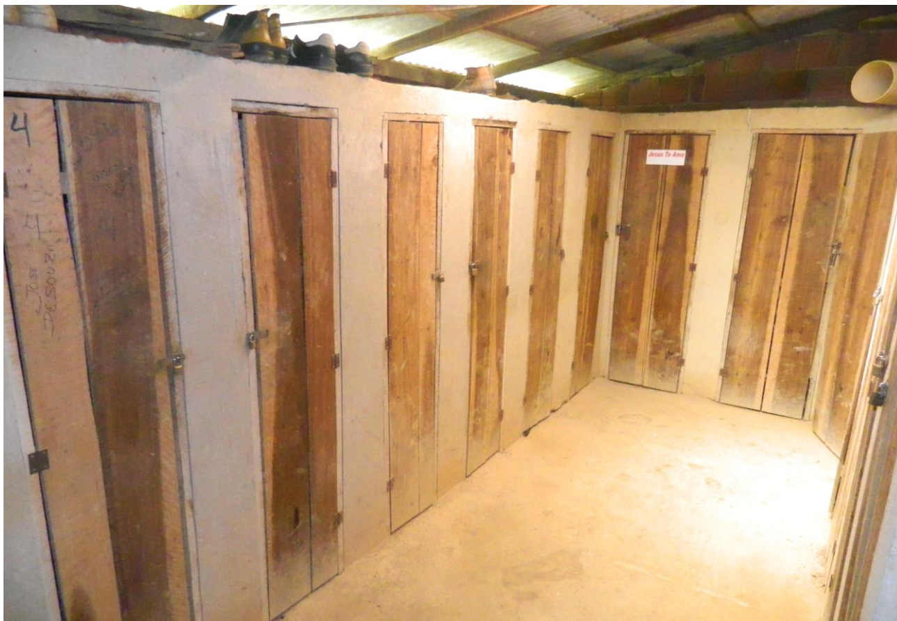
Foto 01 – vestiário e refeitório dos trabalhadores condições inadequadas.
