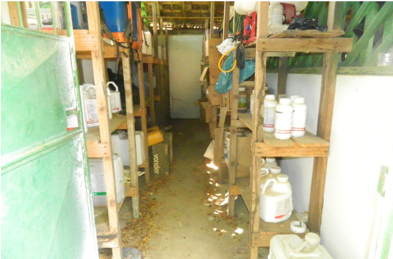
Foto 03 – armazenamento de defensivos perto de outros ambientes, situação inadequada.
