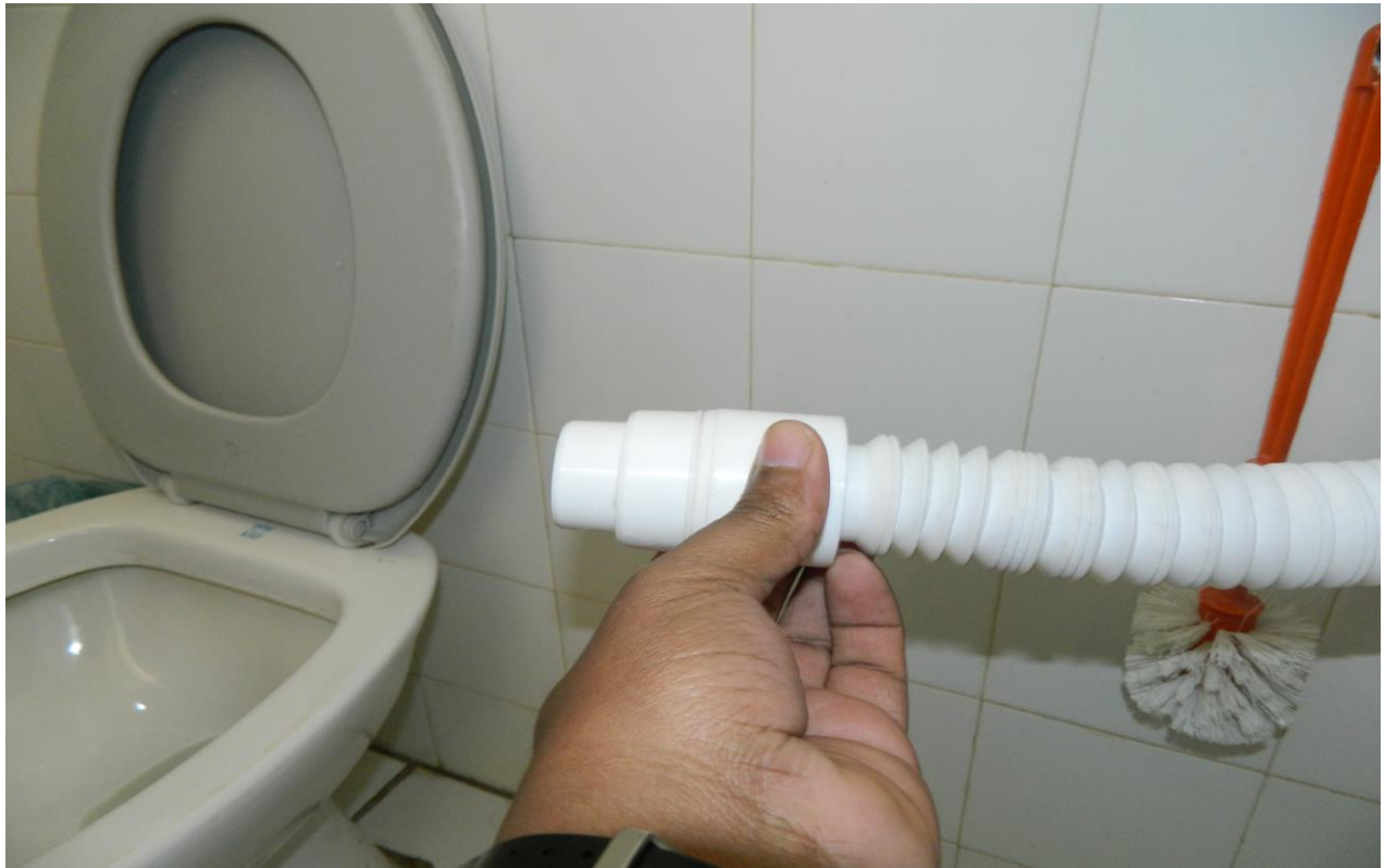
Foto 05 – limpeza do vaso sanitário através de balde no sifão do lavatório.
