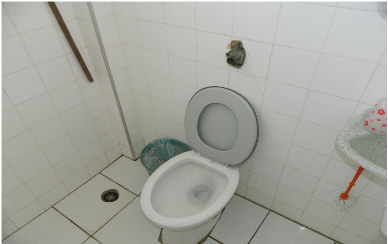
Foto 06 – vaso sanitário no banheiro feminino com descarga quebrada.
