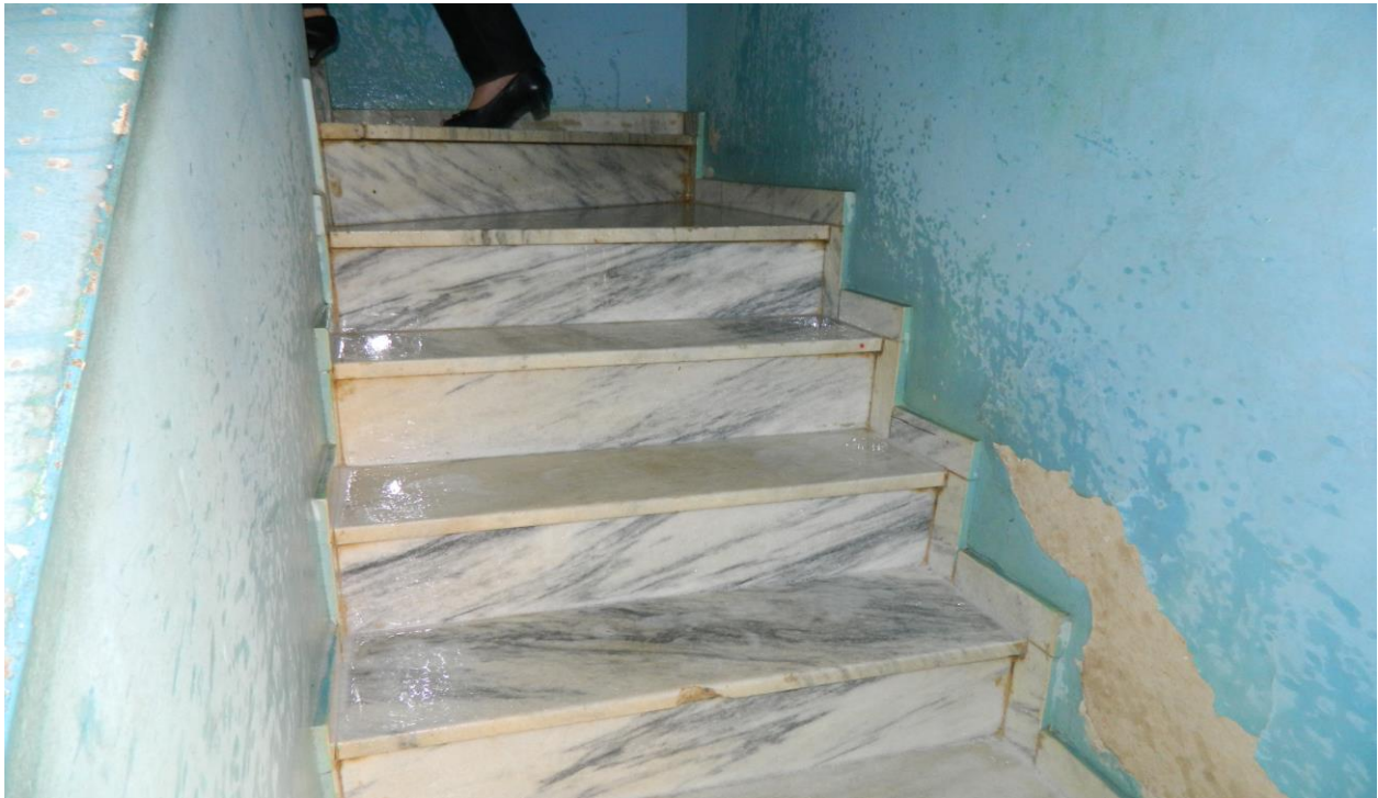
Foto 07 – escada sem acessibilidade para, servidores estaduais, idosos e cadeirantes.
