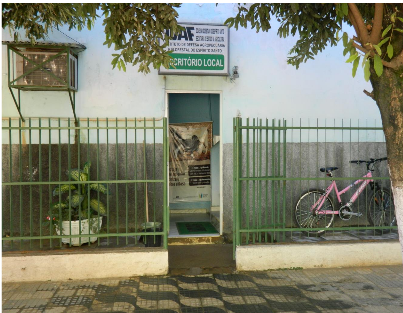
Foto 01- Local de atendimento de usuários idosos, devido o difícil acesso as salas no 2º andar.
