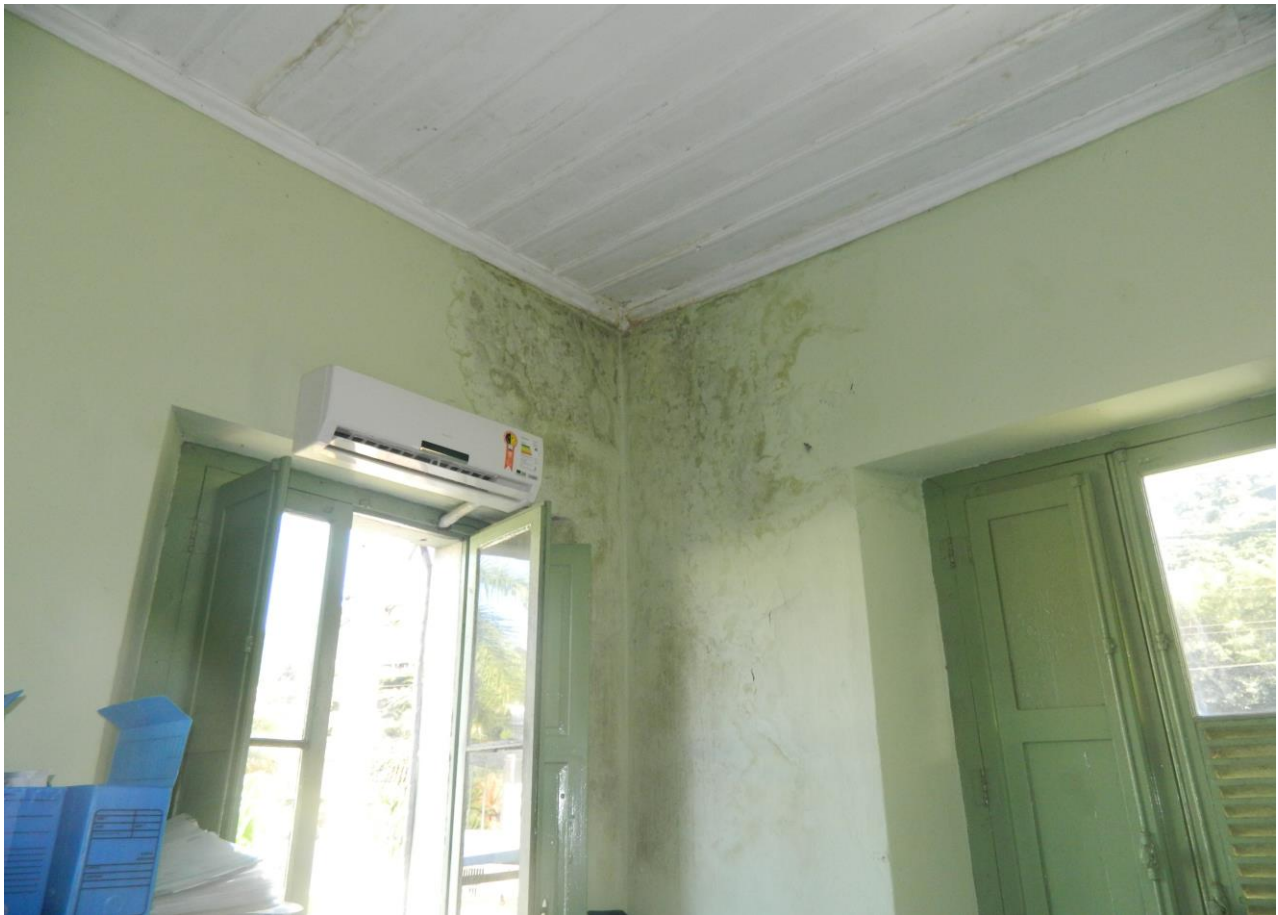
Foto 02- salas com infiltrações, no IDAF e no INCAPER.
