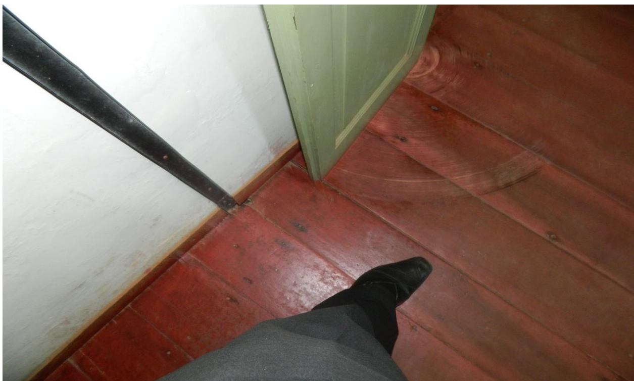
Foto 04 – assoalho de madeira afundando.
