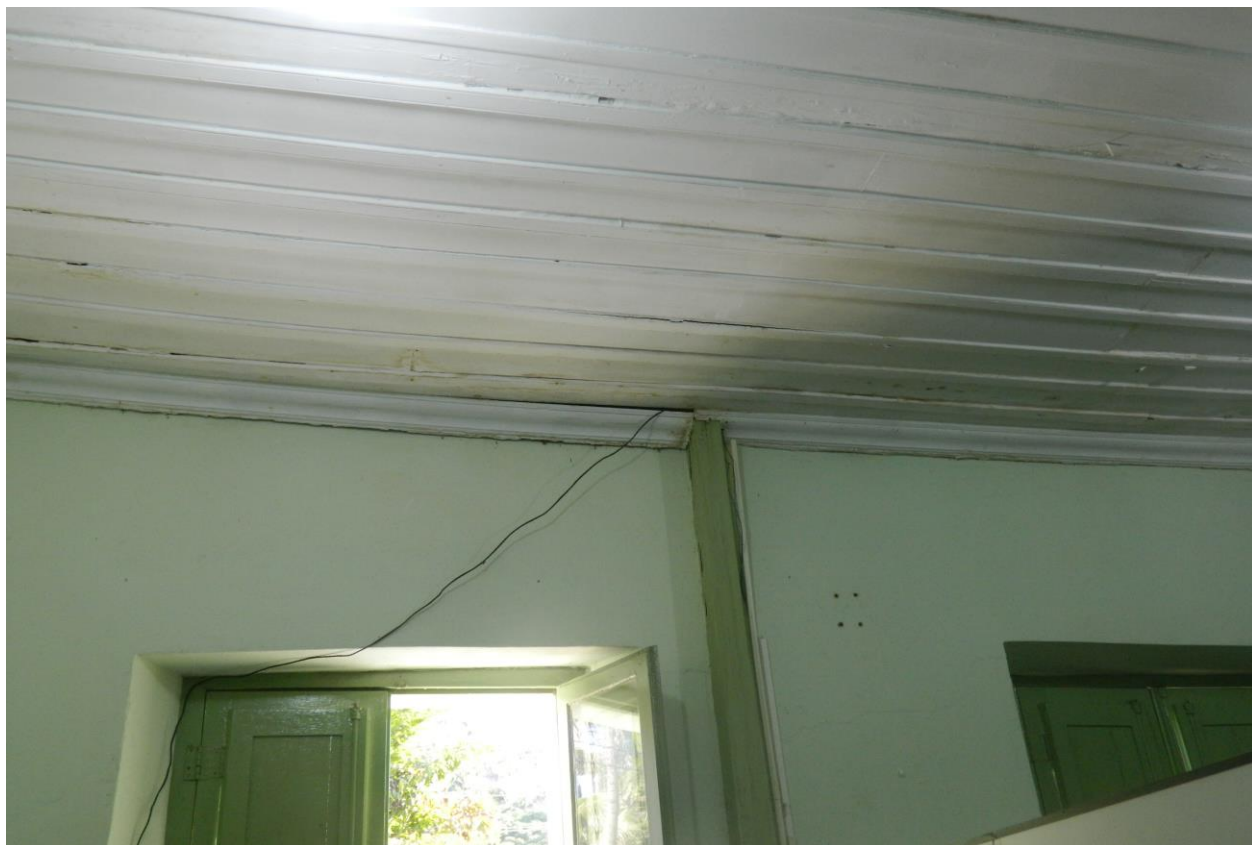
Foto 03 – desprendimento de sanca de madeira no IDAF e INCAPER.
