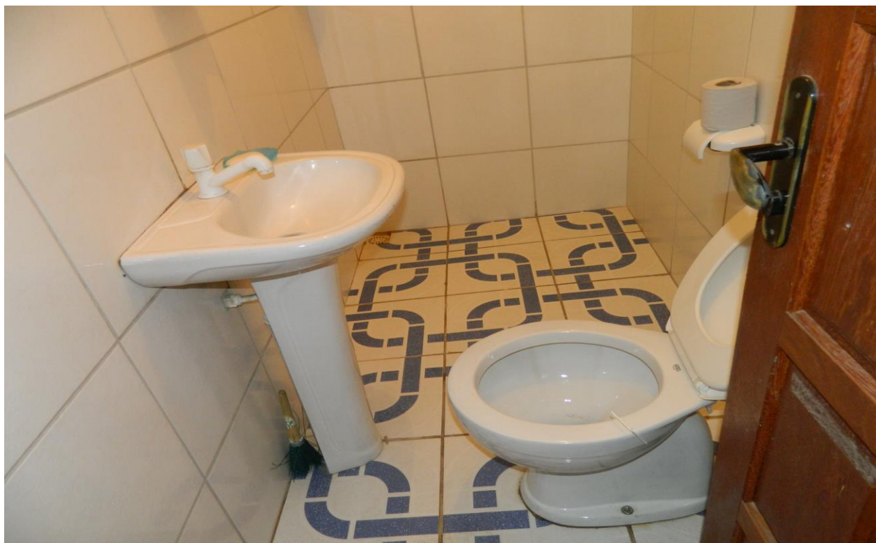
Foto 10 – vaso sanitário muito próximo ao lavatório no banheiro masculino coletivo.
