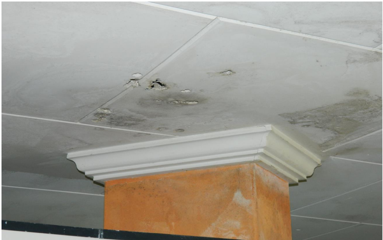
Foto 06 – infiltração no teto do INCAPER.
