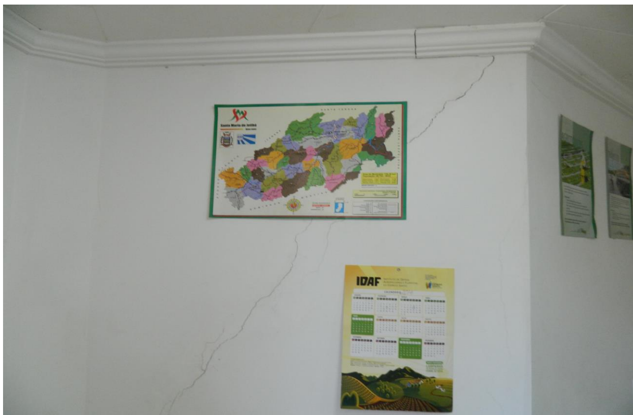
Foto 04 – rachadura na parede no IDAF.
