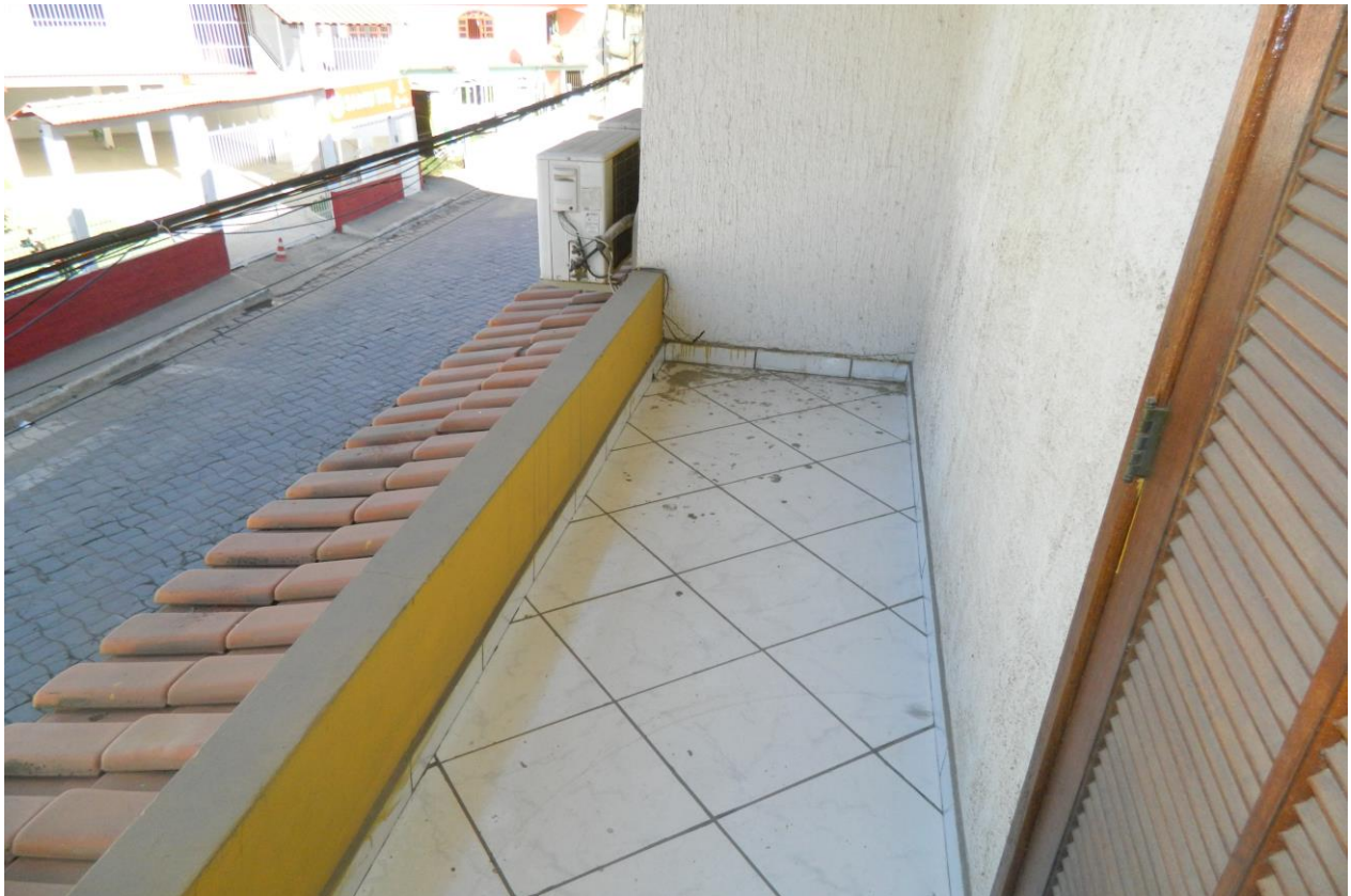
Foto 02- varanda no 2º andar sem guarda corpo, no IDAF e no INCAPER.
