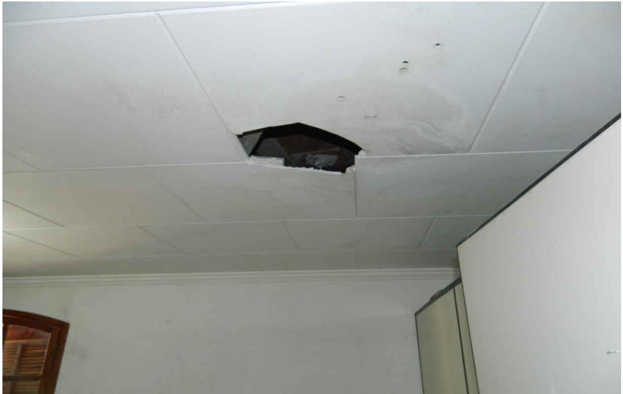
Foto 05 – desprendimento de gesso no INCAPER.
