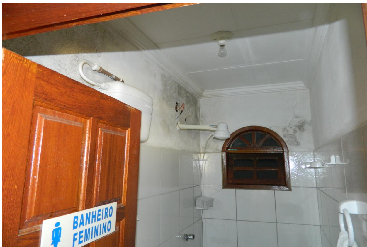
Foto 09 – banheiro feminino coletivo para servidores do IDAF, INCAPER e usuários dos órgãos.
