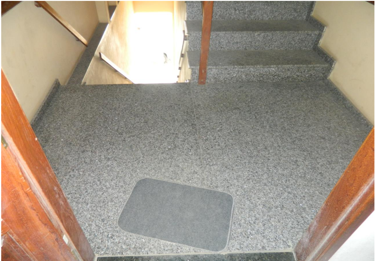
Foto 13 – escada sem acessibilidade para servidores estaduais, idosos e cadeirantes.
