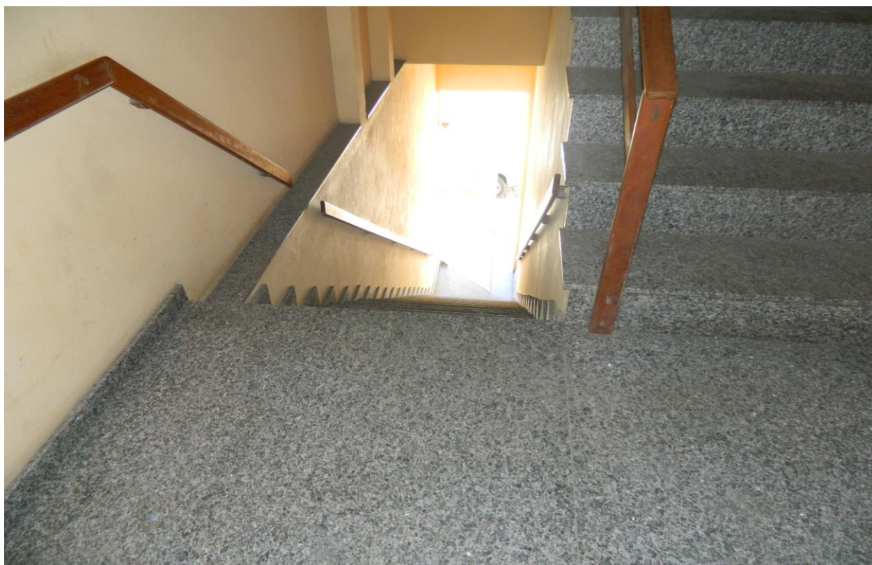
Foto 07 – escada escorregadia, mal sinalizada e sem acessibilidade.
