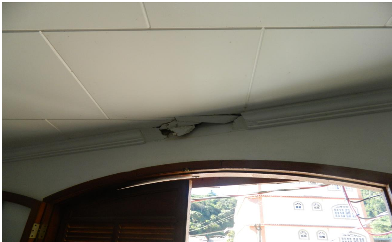
Foto 03 – desprendimento de gesso no IDAF e INCAPER.
