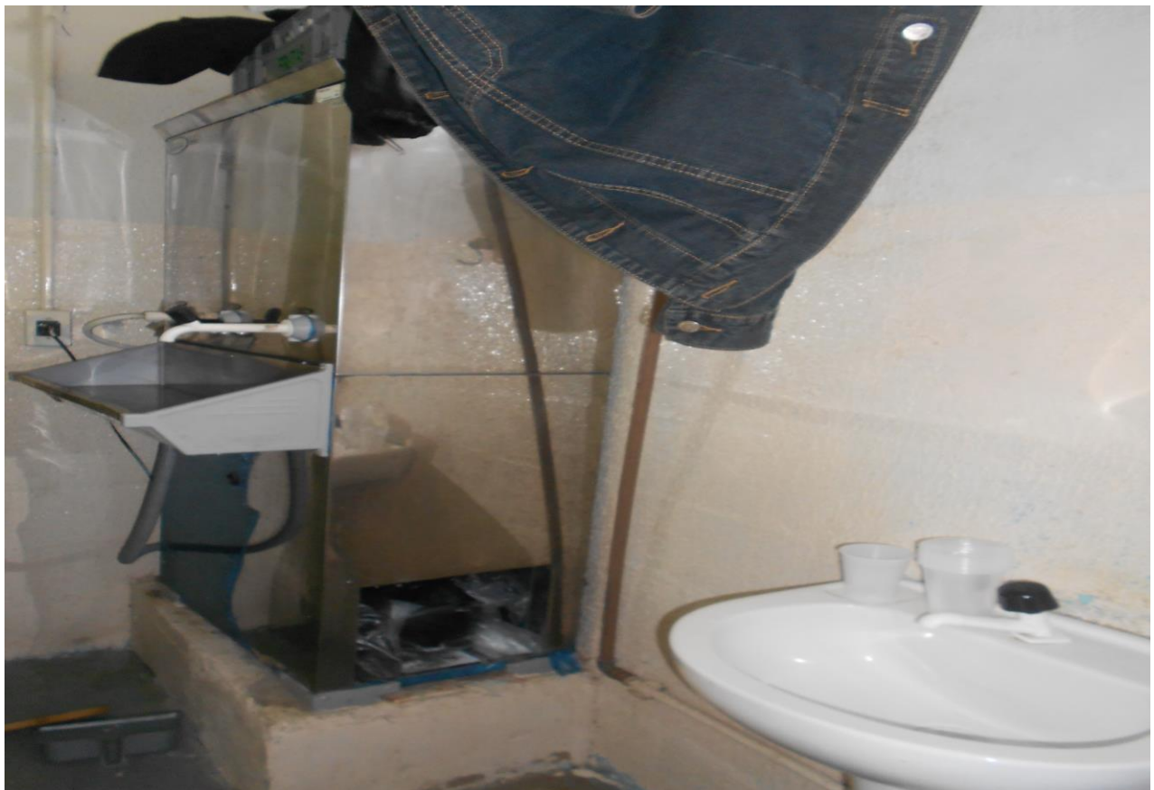
Foto 02 – bebedouro em banheiros nas moradias.
