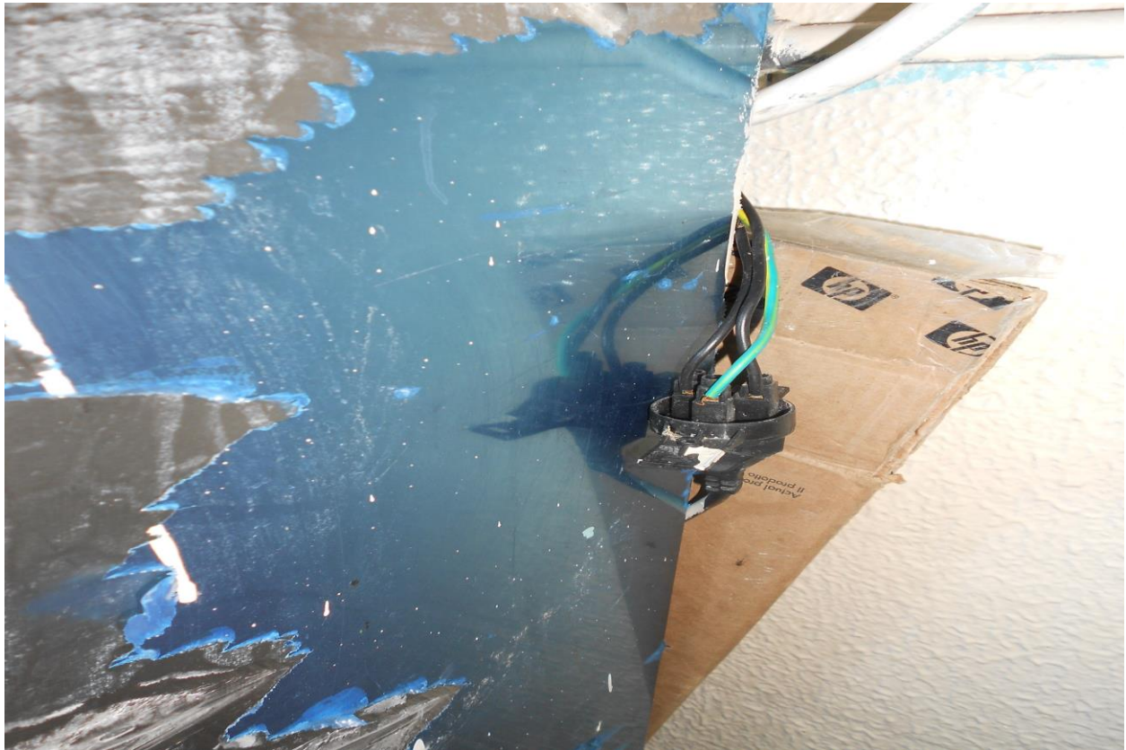
Foto 06 – exposições de fios nos bebedouros nas moradias.
