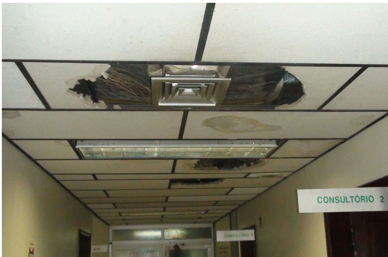
Foto 06 – desprendimento de gesso no ambulatório 02.
