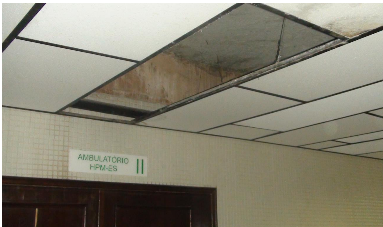
Foto 07 – desprendimento de gesso no corredor do ambulatório 02.
