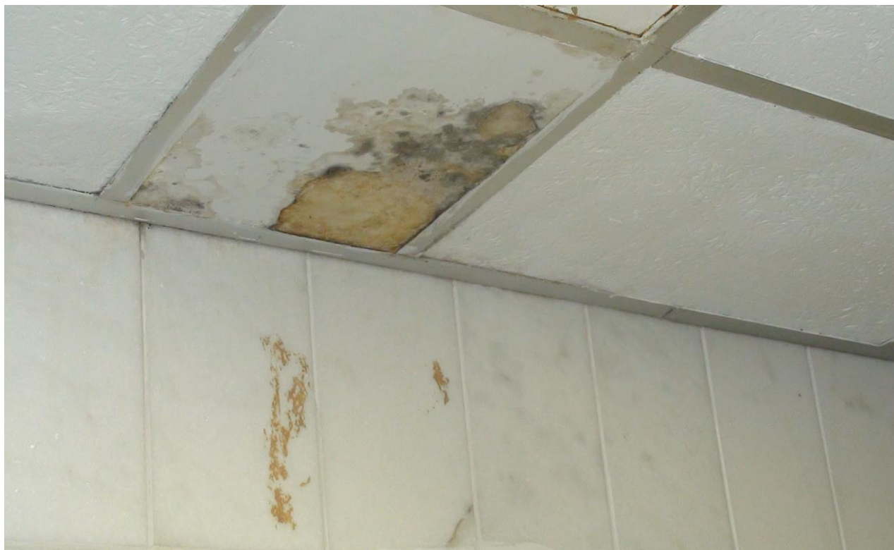
Foto 03 – infiltração no corredor do administrativo.
