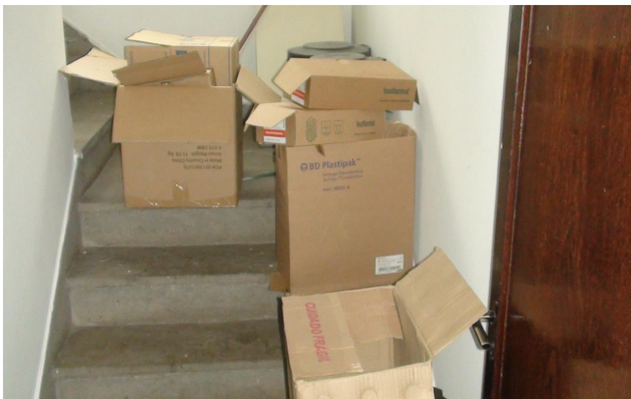
Foto 10 – caixas de papelão na escada de saída de emergência.
