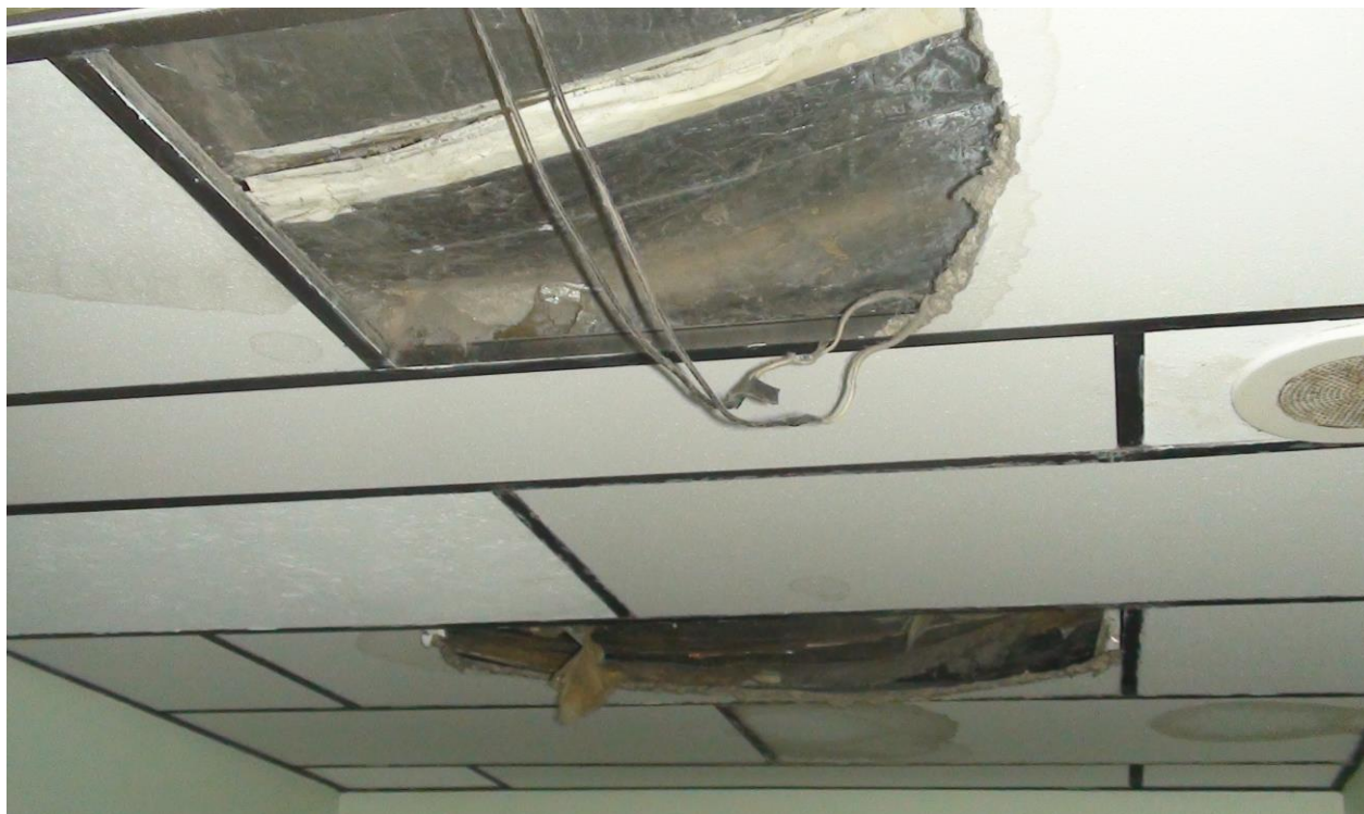
Foto 05 – desprendimento de gesso no ambulatório 02.
