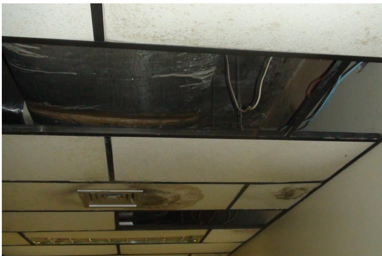
Foto 08 – infiltração no ambulatório 02.
