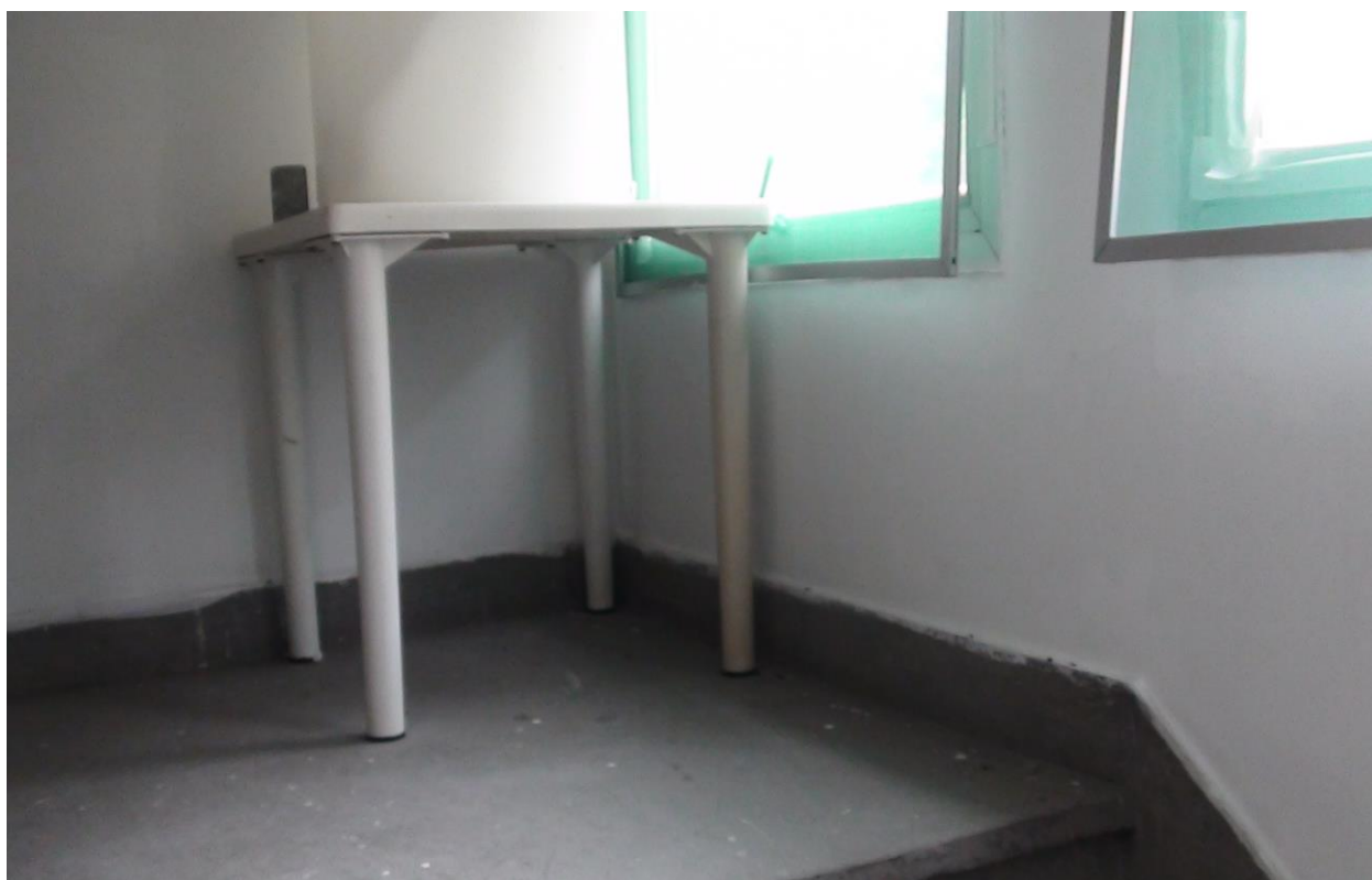
Foto 12 – mesa na escada de emergência.
