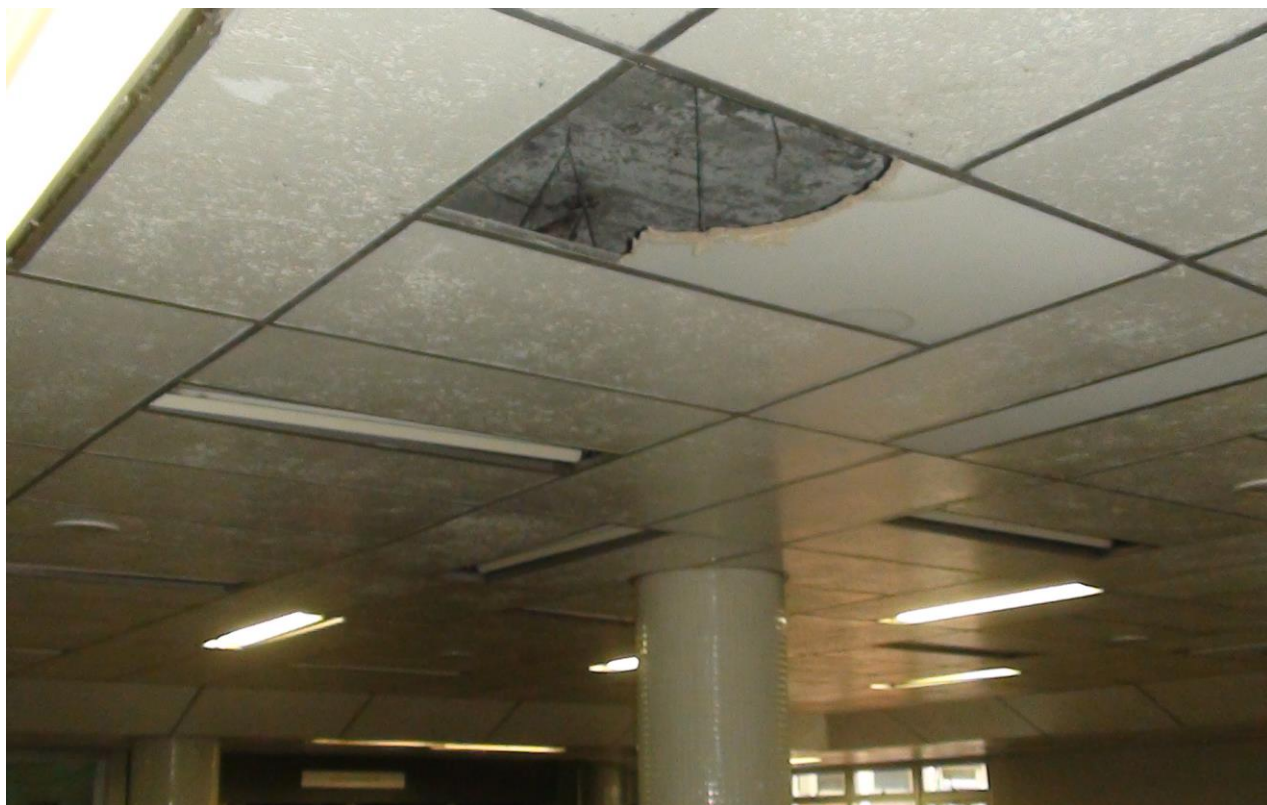
Foto 04 – desprendimento de gesso do teto na portaria central.
