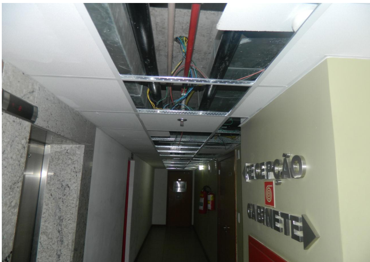
Foto 04- escuridão no hall de entrada e extintores vencidos.
