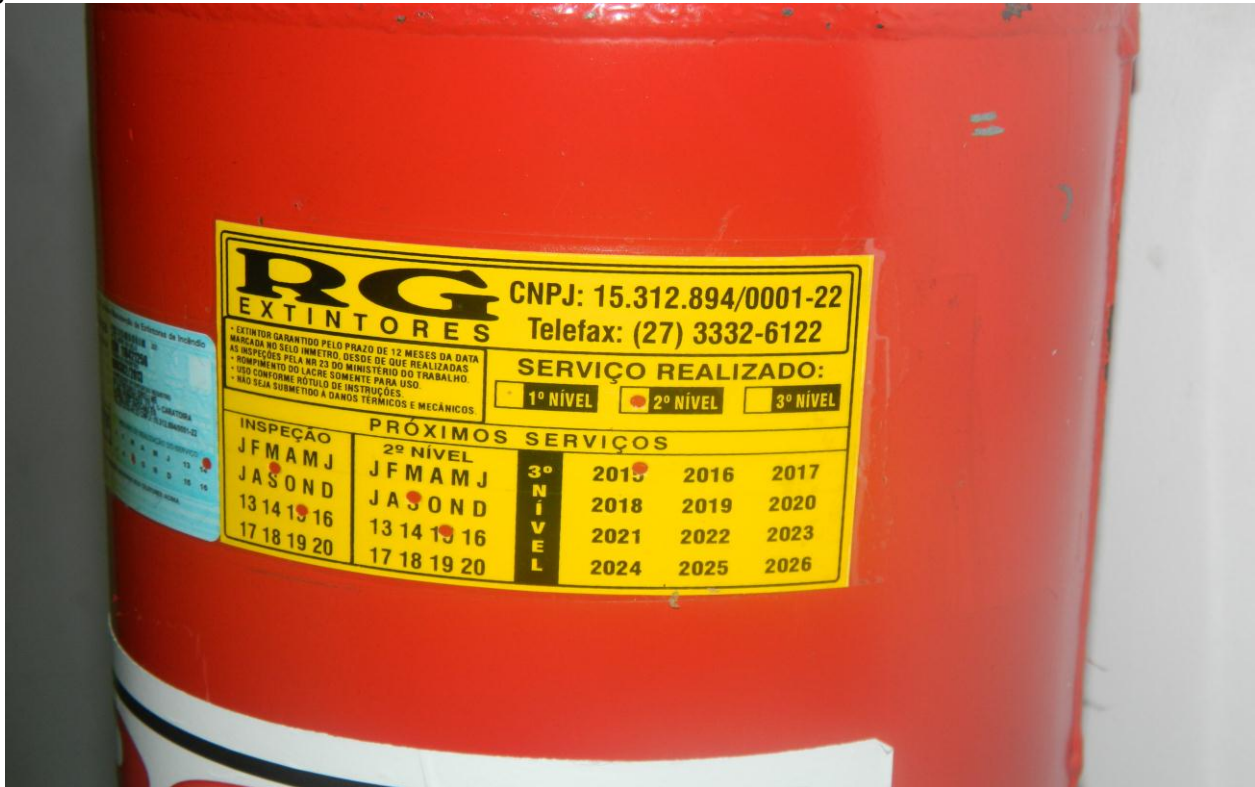
Foto 03- todos os extintores do hall de entrada estão vencidos.
