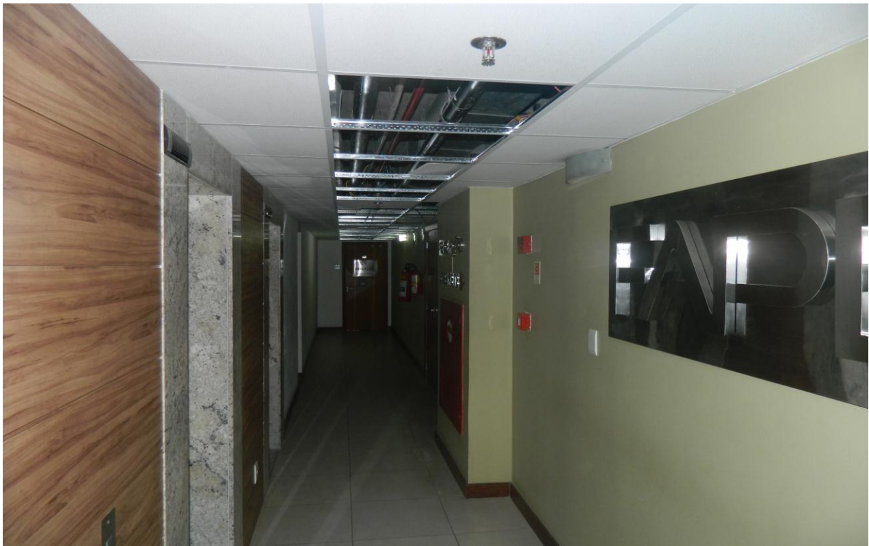
Foto 02- hall de entrada com insuficiência de iluminação e desprendimento de forro de gesso.
