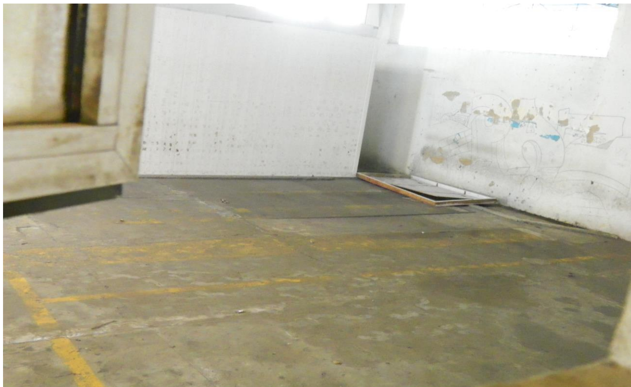
Foto 03 – ginásio abandonado com buracos, anexo ao DETRAN.
