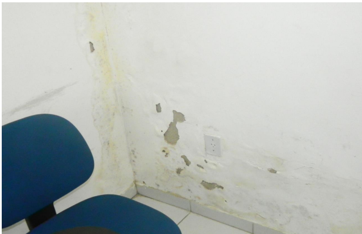
Foto 04 – infiltrações na sala de prova.
