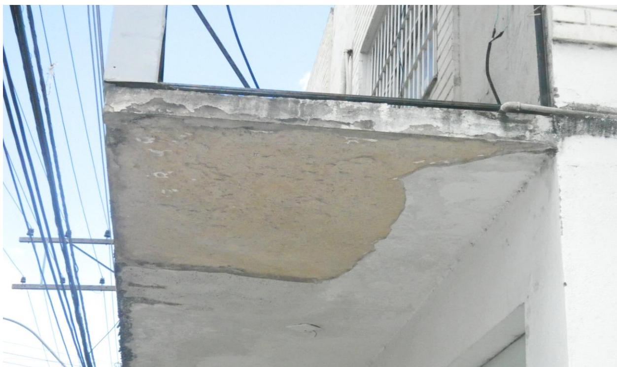
Foto 05 – desprendimento de reboco da marquise.
