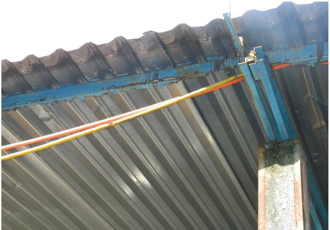
Foto 02 - cobertura do pátio em avançado estado de corrosão.
