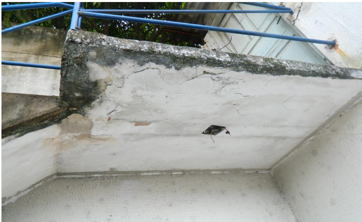
Foto 04 – patamar da escada em cima do refeitório.
