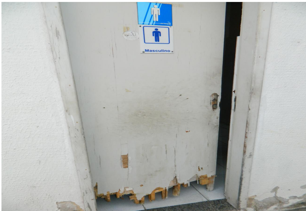
Foto 07 – portas quebradas dos banheiros masculino e feminino.
