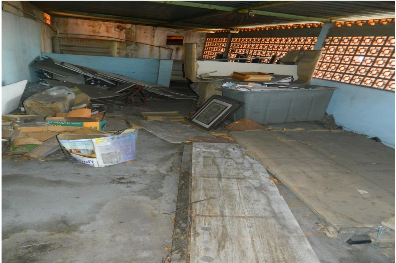
Foto 09 – muito lixo no segundo pavimento em cima do refeitório.
