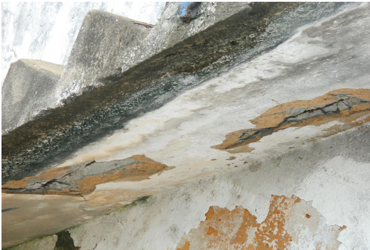
Foto 03 - desprendimento de reboco e aparecimento das ferragens na escada.
