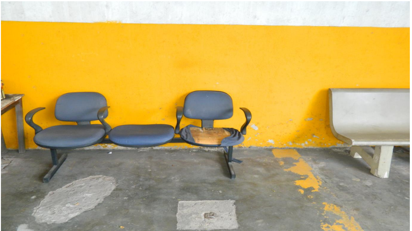
Foto 08 – mobília quebrada no atendimento ao cliente.
