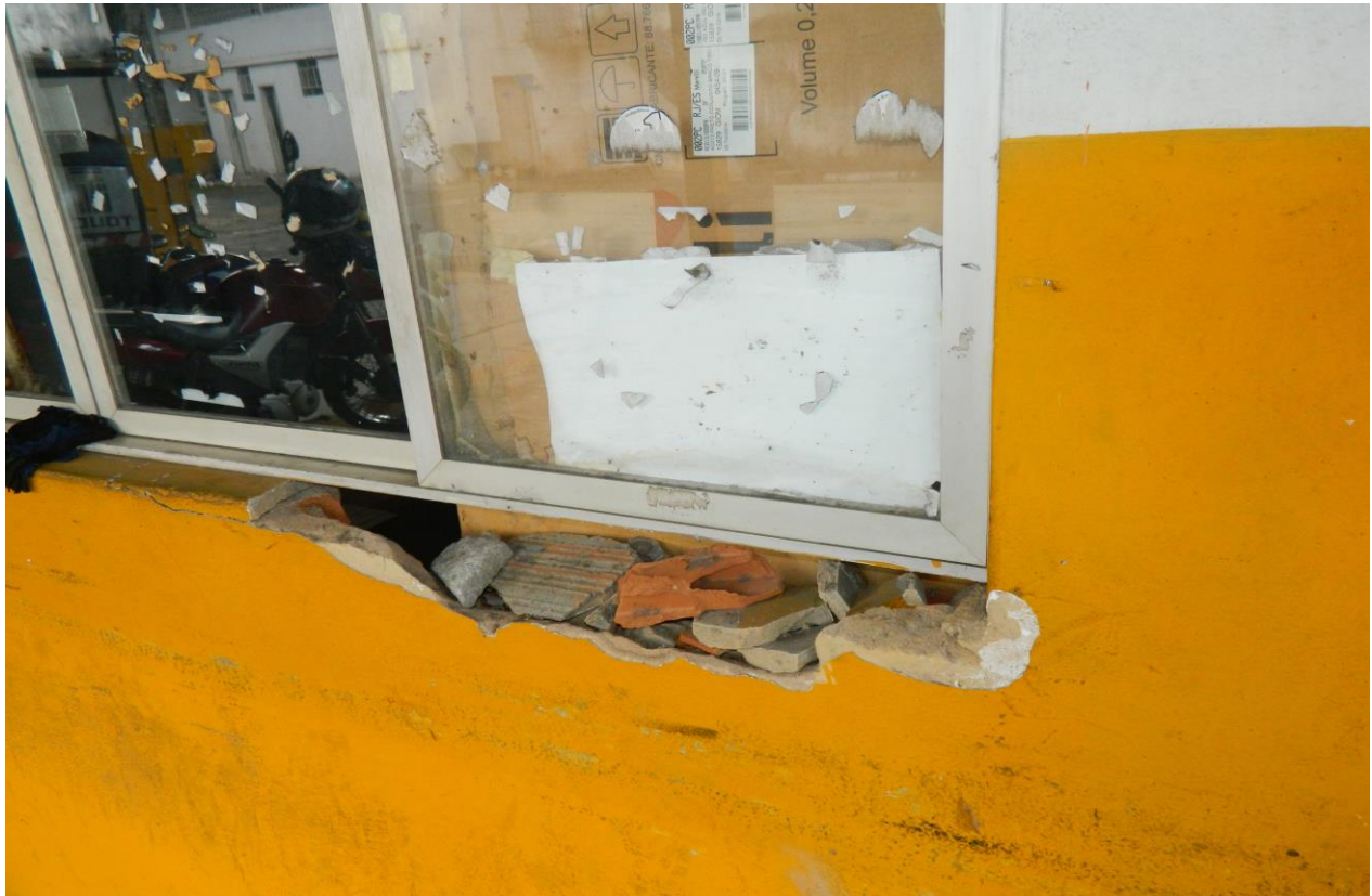
Foto 05 – sala de ferramentas com a janela caindo.
