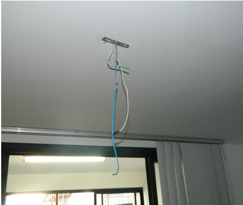
Foto 03 - Instalação inadequada
