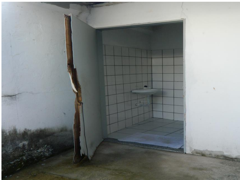
Foto 01 - Banheiro com porta quebra e sem identificação masculino/feminino
