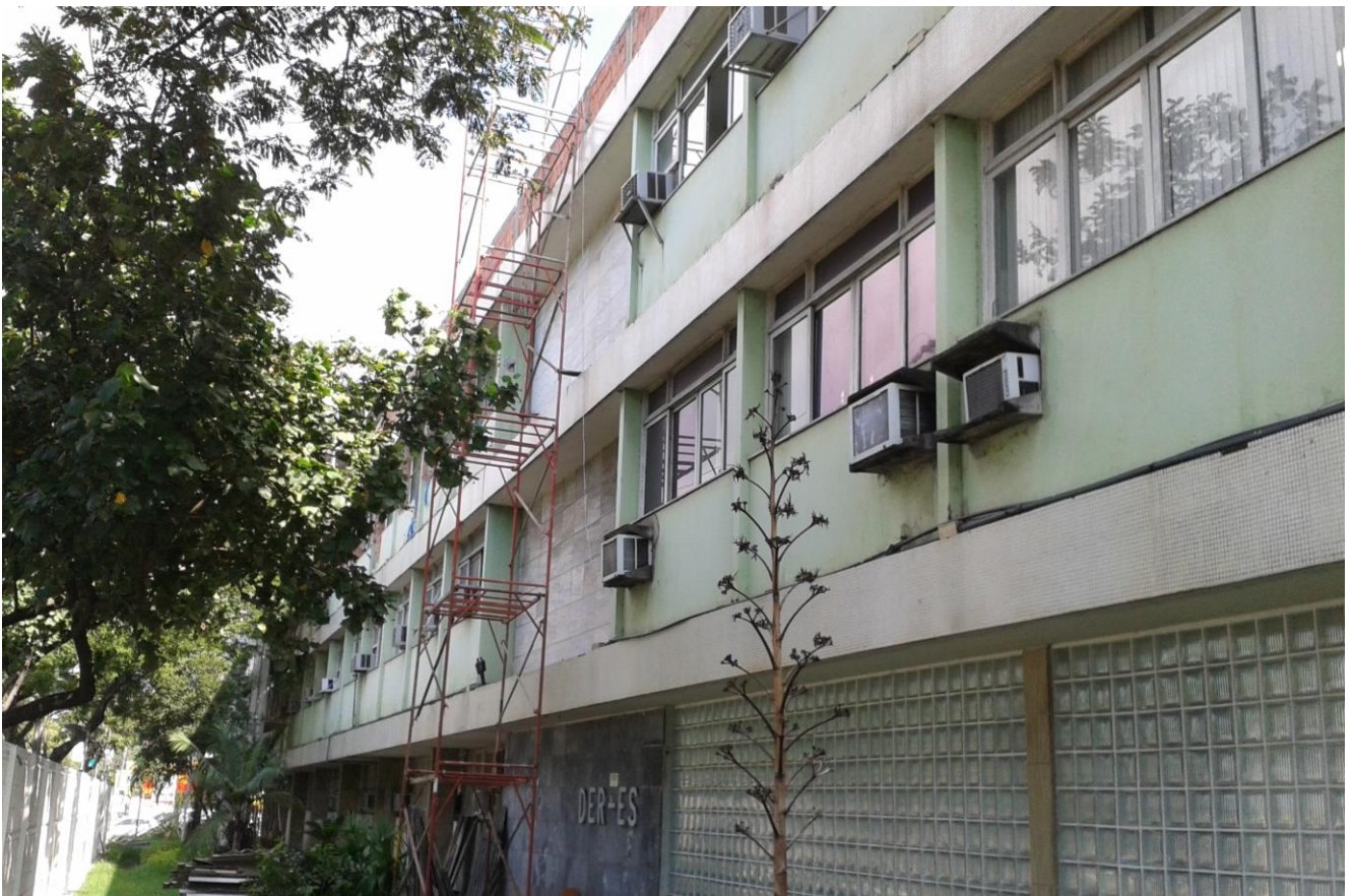
Foto 01- fachada sem sinalização e segurança.
