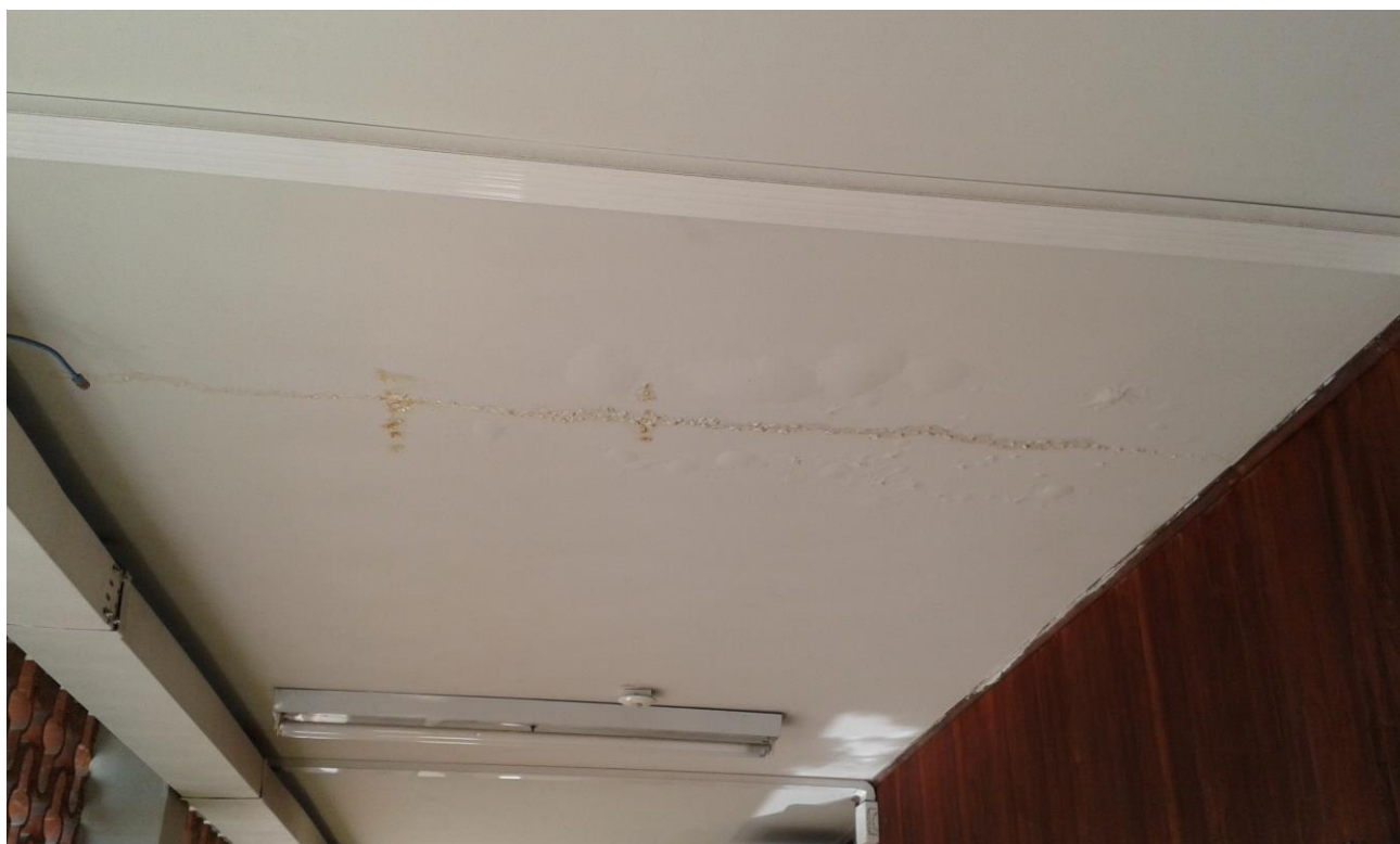
Foto 05- infiltração nos corredores devido as obras.
