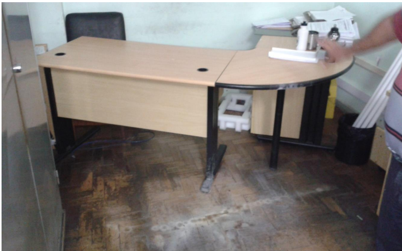
Foto 06- sala de apoio técnico com infiltrações devido às obras.
