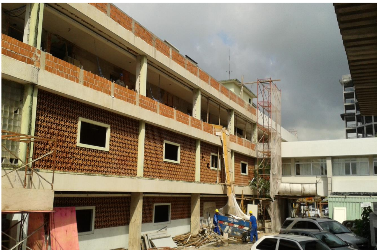
Foto 07- fachada em obra com risco de queda de matérias.
