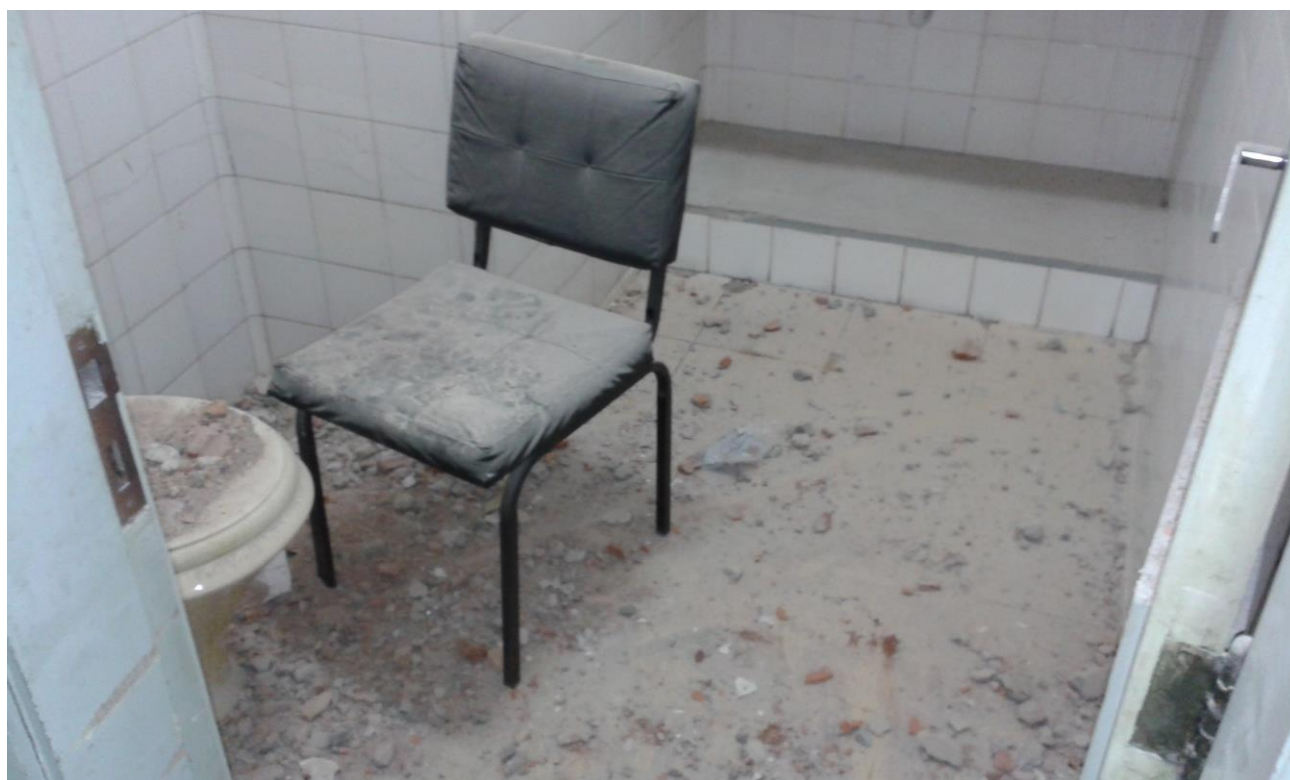
Foto 03- banheiro danificado no 2º andar devido á falta de proteção na fachada.
