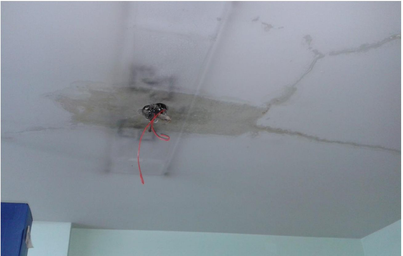
Foto 08- parte elétrica danificada e muitas infiltrações.
