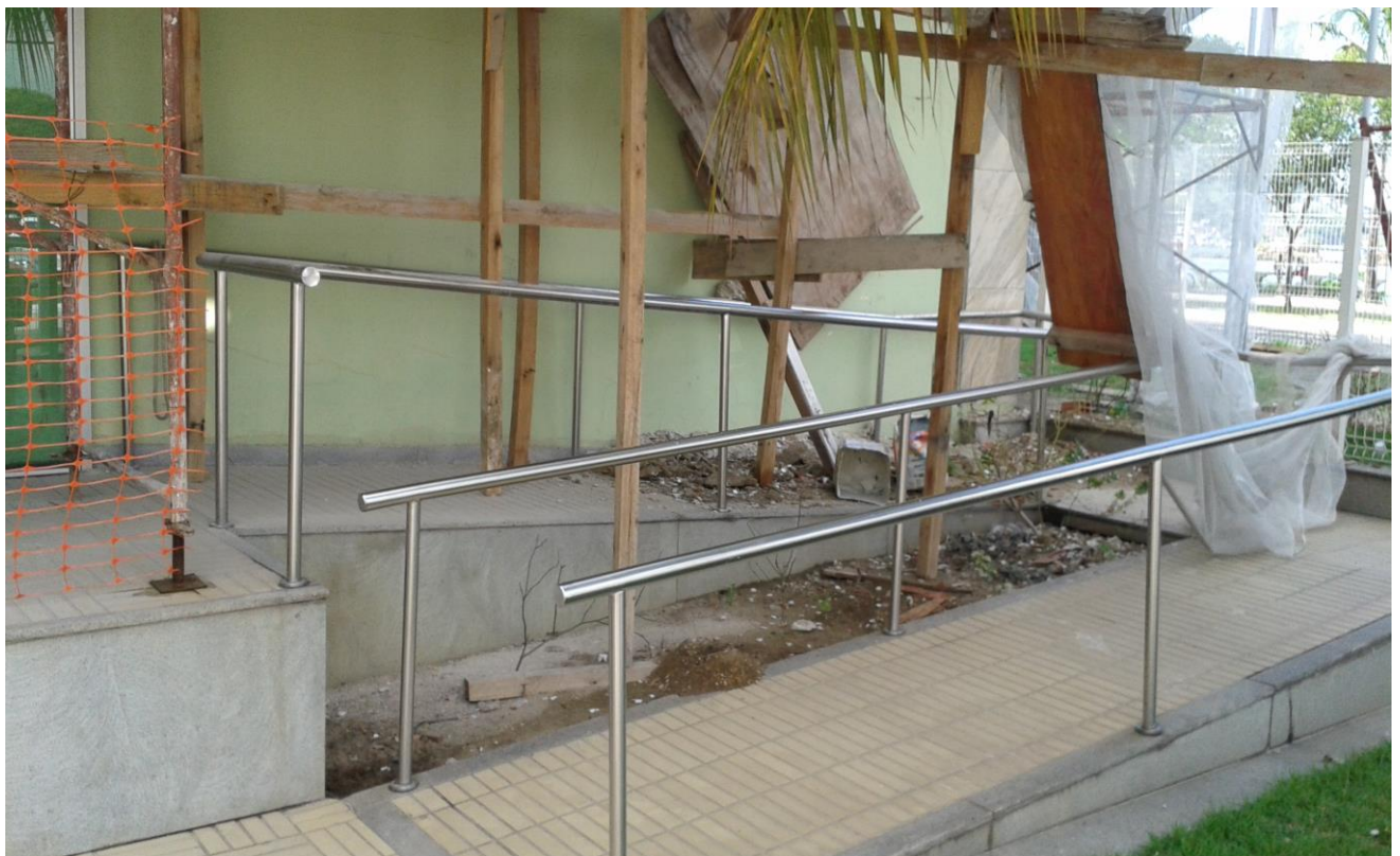
Foto 09- rampa de acessibilidade obstruída.
