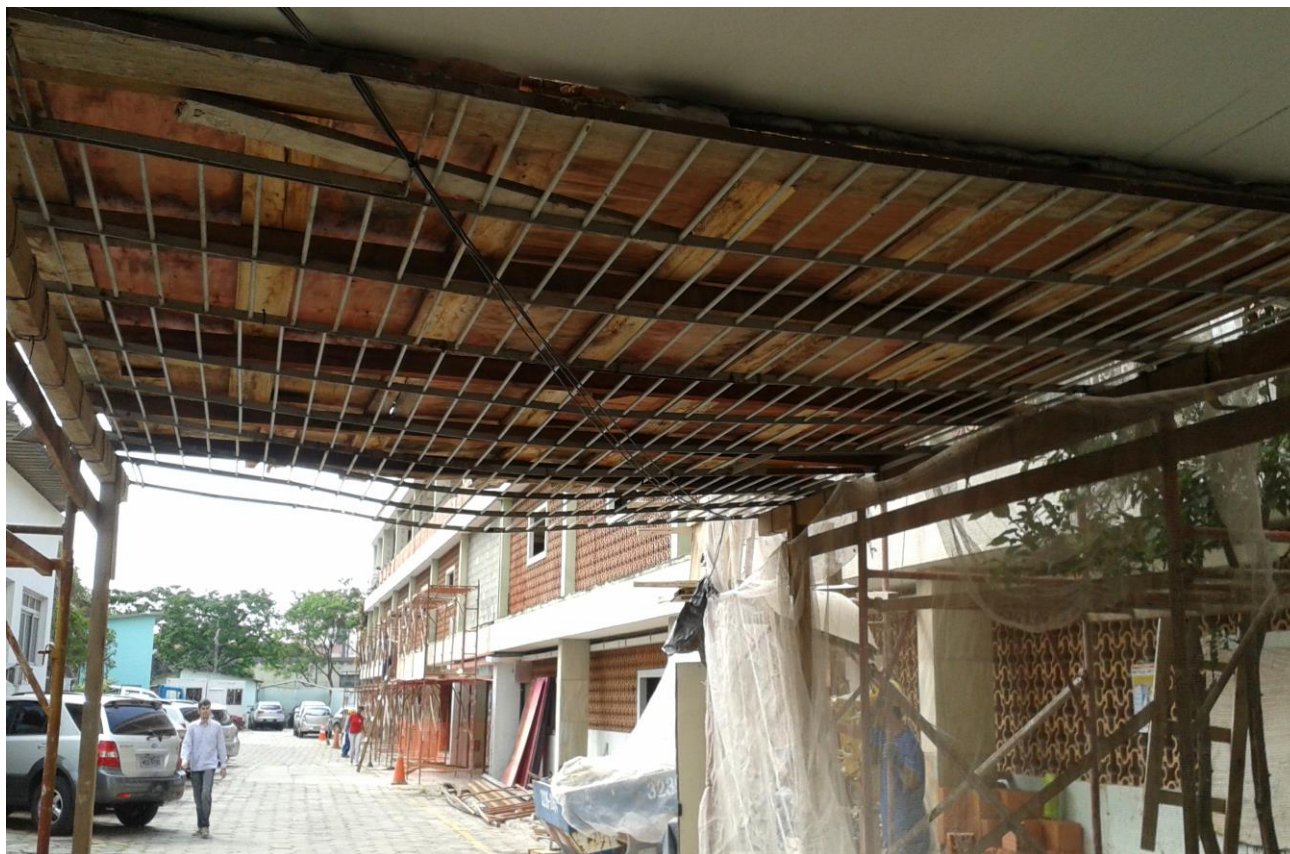
Foto 02 – grade de ferro sobrecarregando galeria na garagem.
