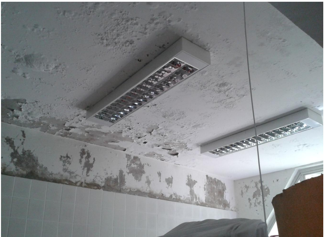
Foto 01 – infiltrações e mofo no setor da lavanderia e manutenção.
