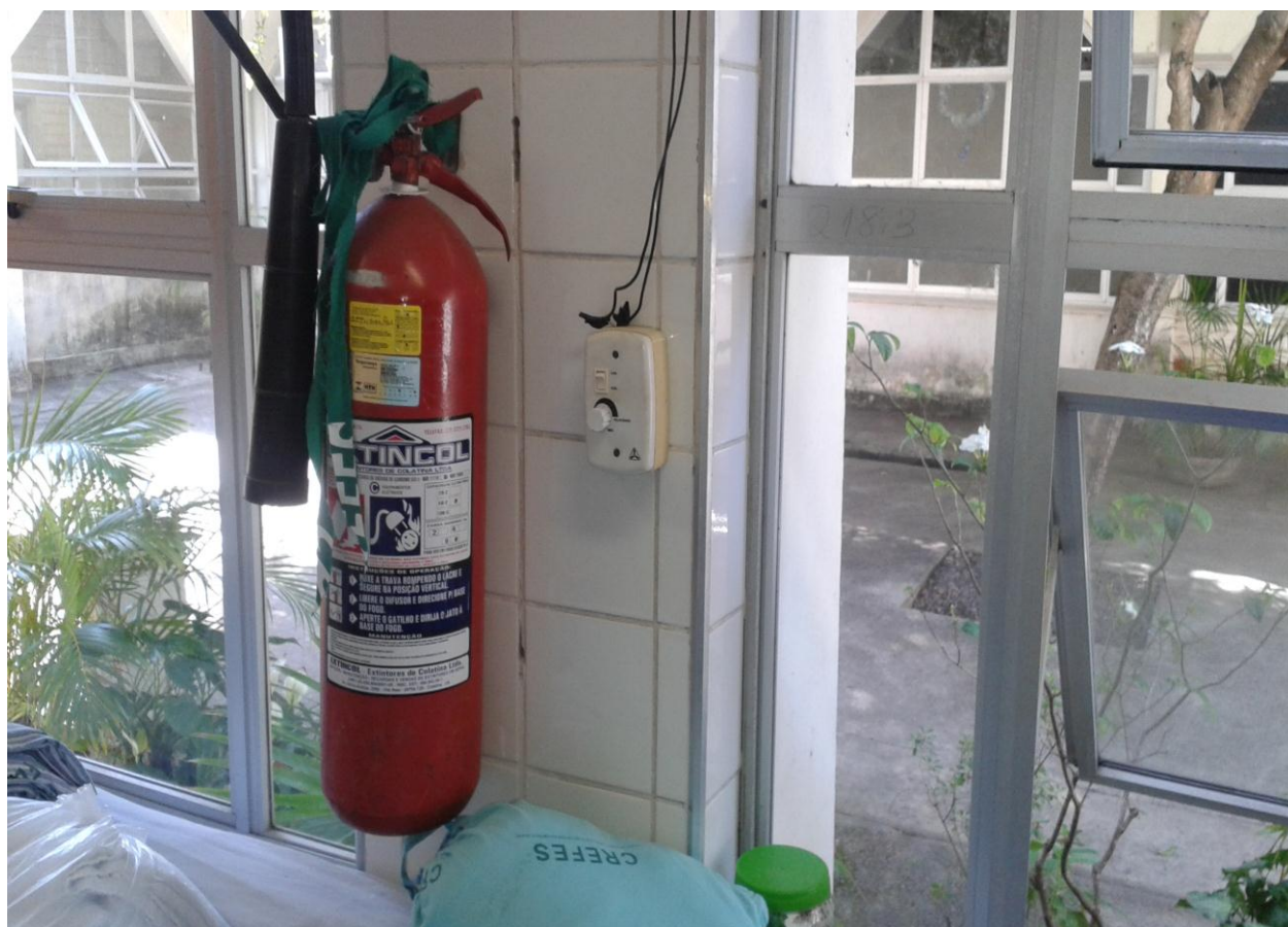
Foto 16 – extintor obstruído na lavanderia e manutenção.
