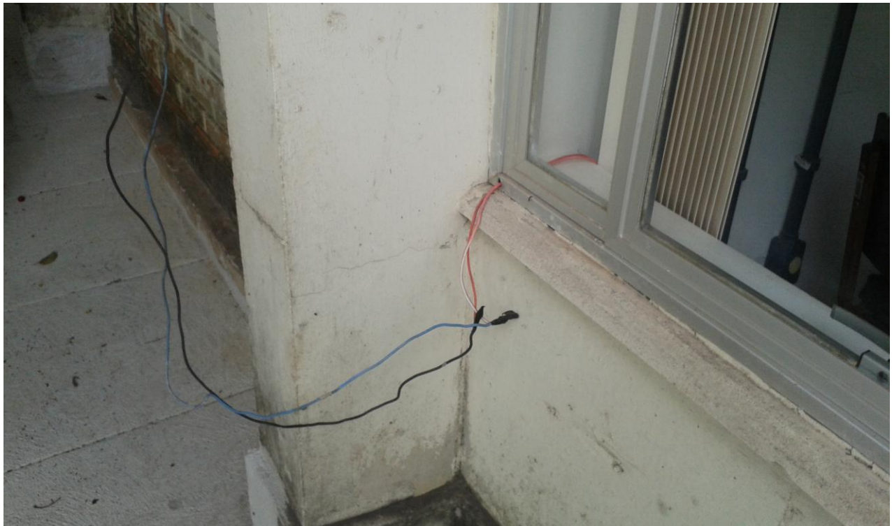
Foto 13 – instalação inadequada na parte externa da unidade de trabalho ambulatorial.
