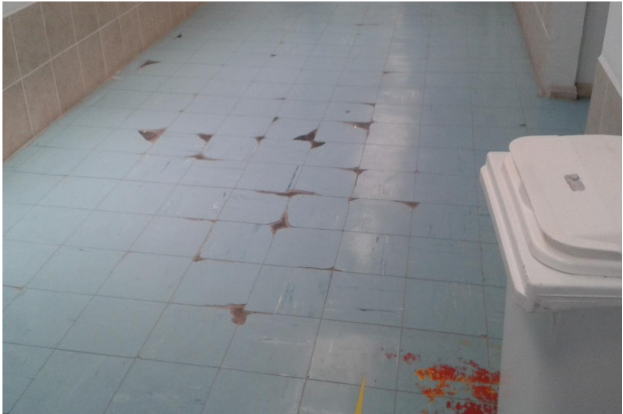
Foto 12 – piso inadequado na UTA unidade de trabalho ambulatorial.
