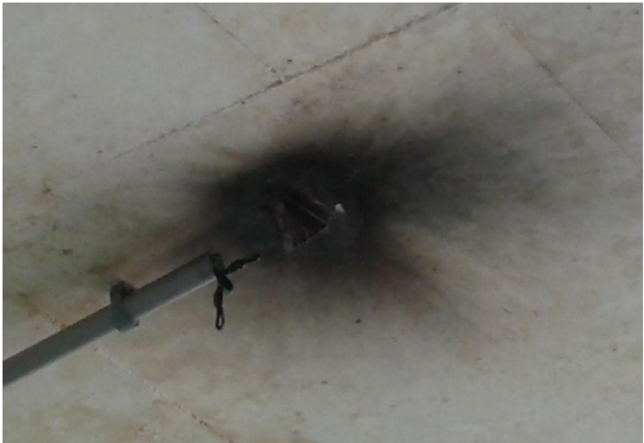
Foto 14 – curto-circuito no teto da copa na unidade de trabalho ambulatorial.
