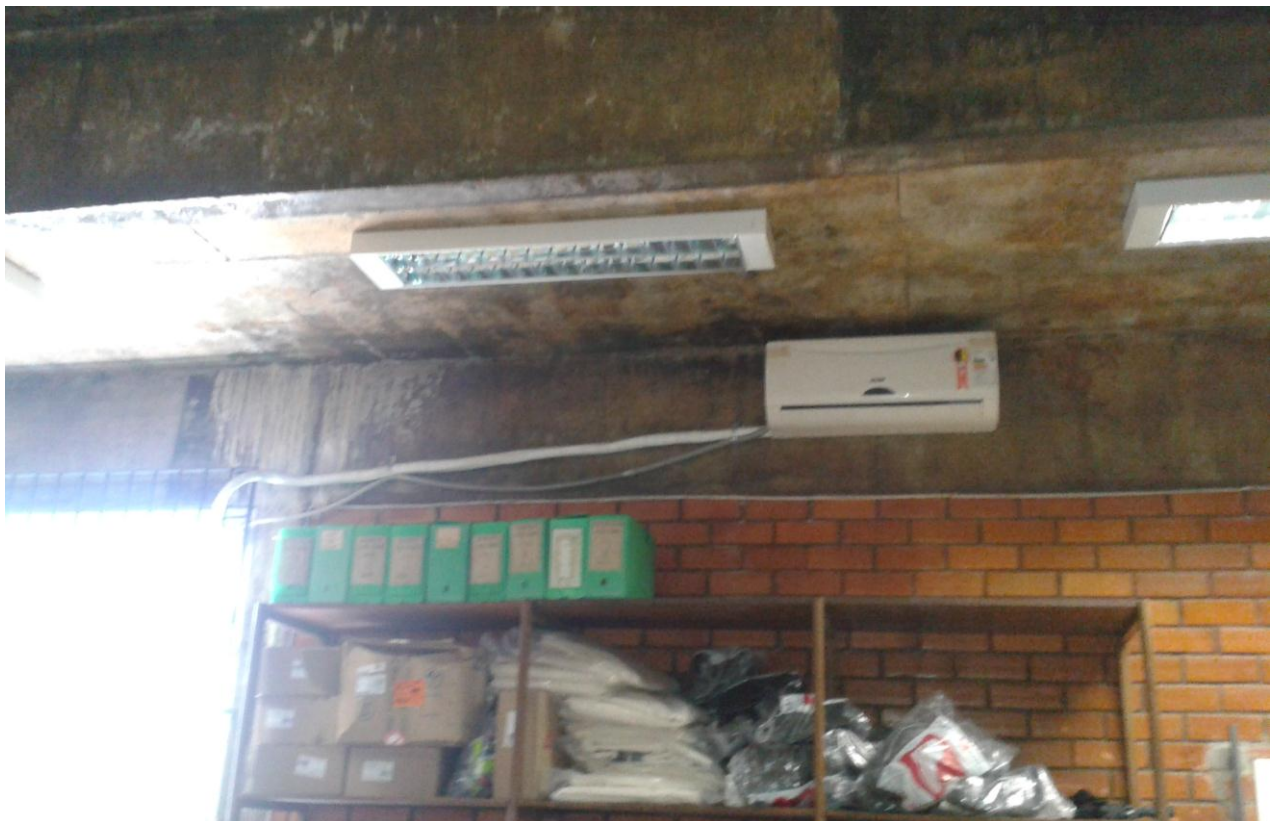
Foto 23 – ar condicionado quebrado no almoxarifado.
