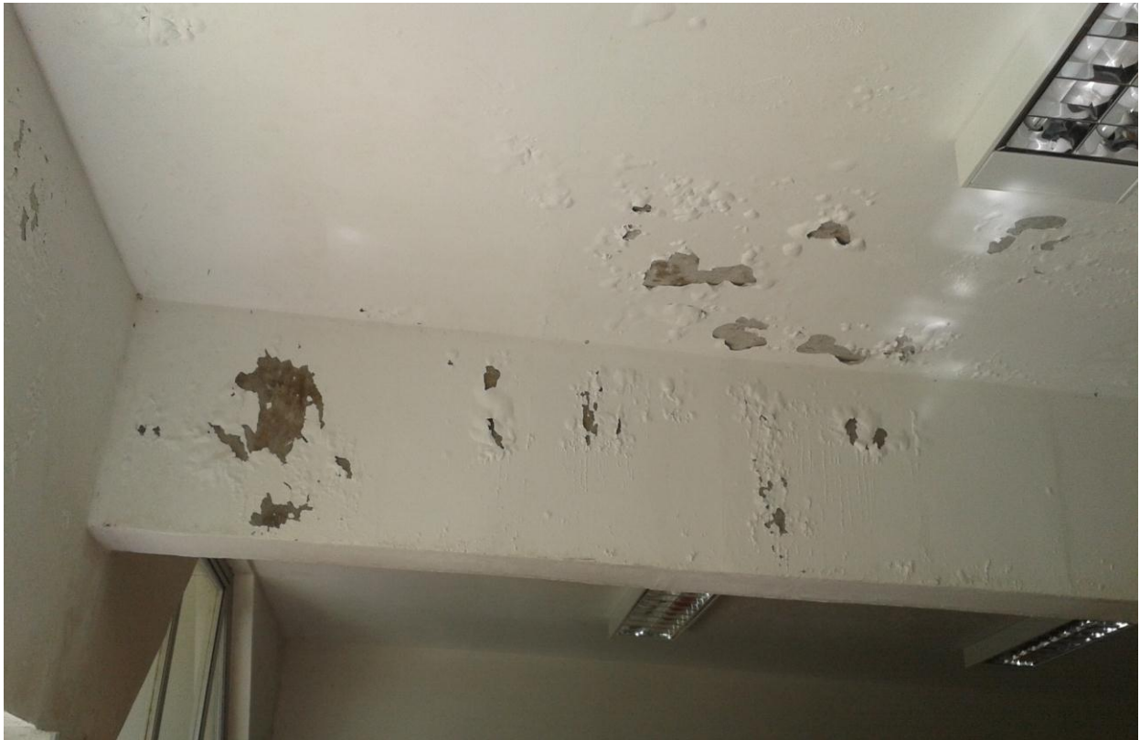
Foto 02 – mofo na sala da lavanderia.
