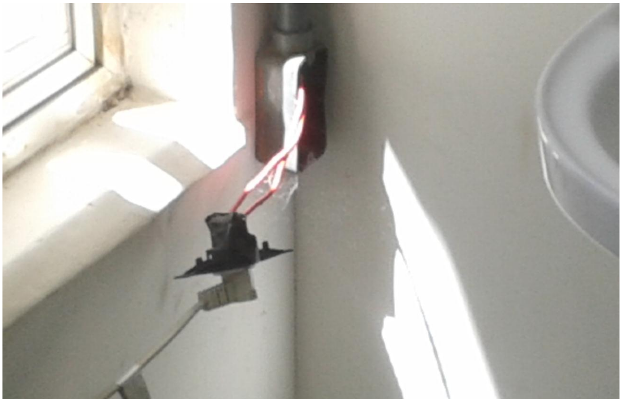
Foto 15 – instalação inadequada do ar condicionado na piscina de tratamento.
