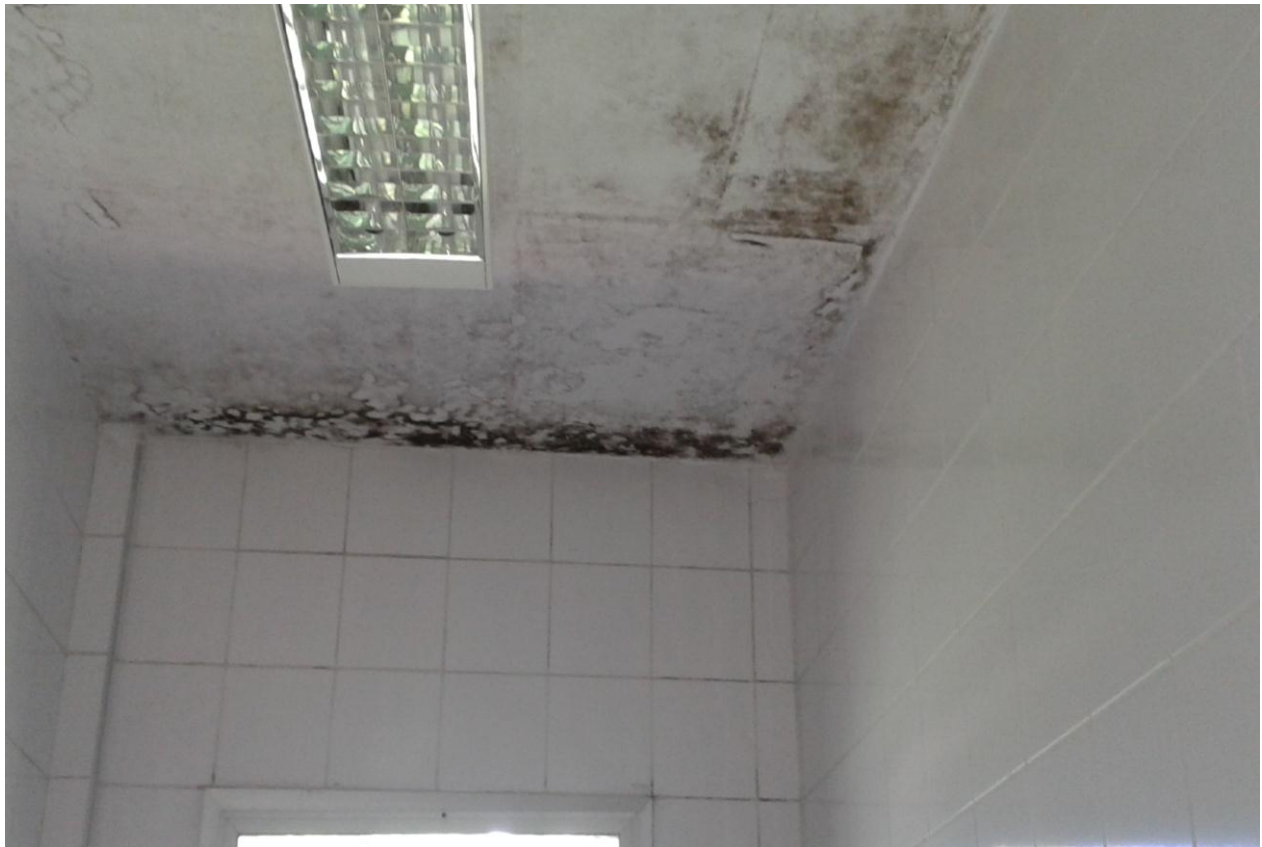
Foto 03 – infiltração na cozinha da unidade de trabalho ambulatorial (UTA).
