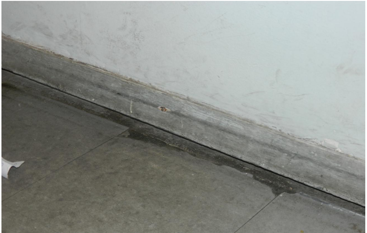
Foto 06 – foto tirada em 14/10/14, afundamento de piso agravado.
