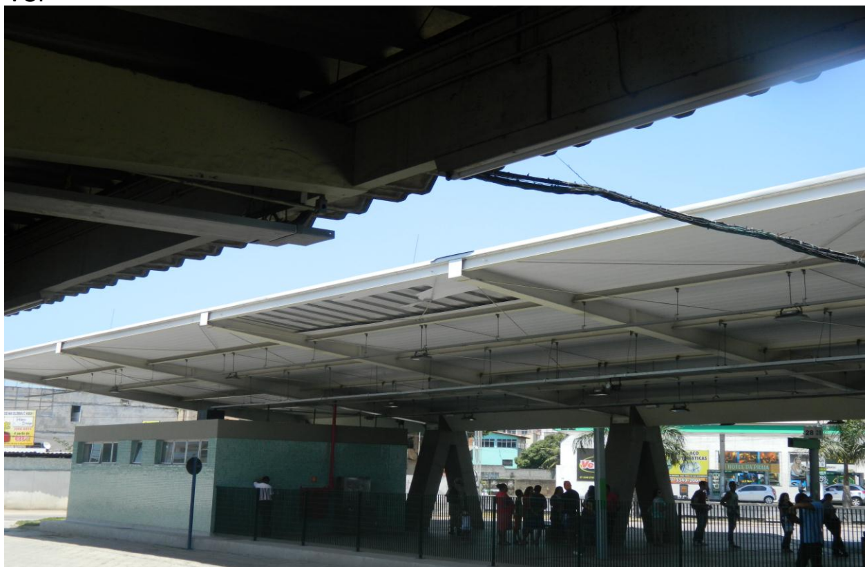
Foto 03 – terminal de Vila Velha, visita do dia 14/10/14, desprendimento de forro e calha de fios de energia.
