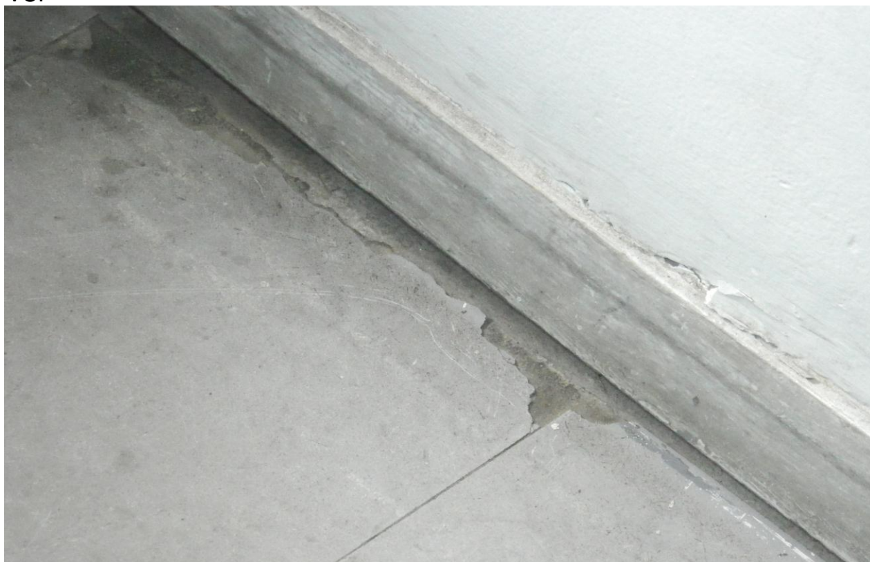
Foto 05 – foto tirada em 21/01/14 na sala dos fiscais da CETURB, afundamento de piso.
