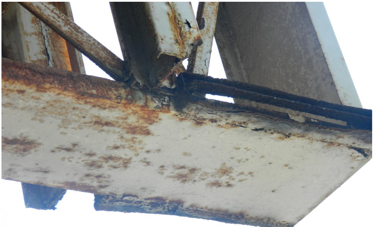
Foto 13 – foto tirada em 14/10/14, estrutura metálica corroída pelo tempo.
