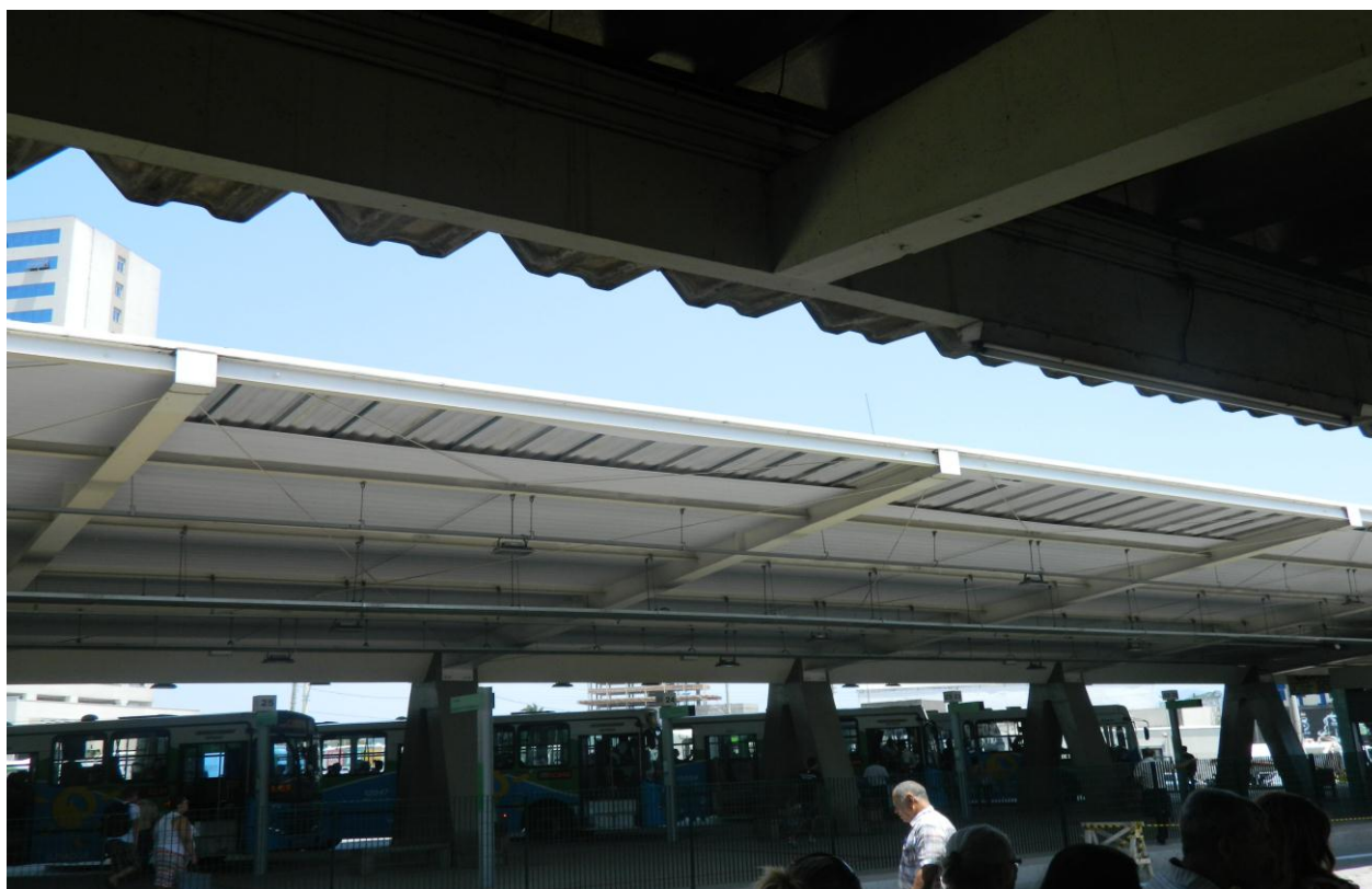
Foto 04 – visita do dia 14/10/14, este e outros pontos de desprendimentos de forro de PVC.
