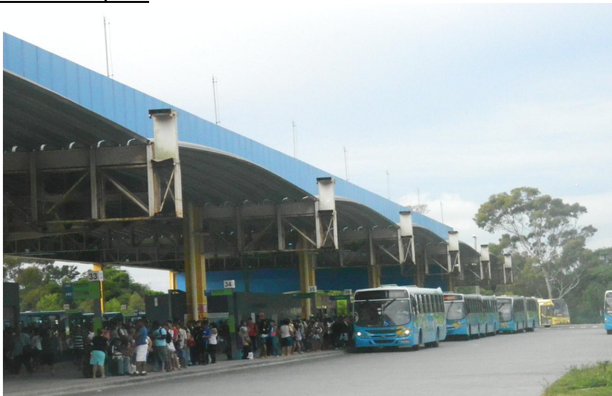
Foto 08 – terminal de Itaparica foto tirada em 21/01/14: estrutura metálica retirada do beiral da cobertura.
