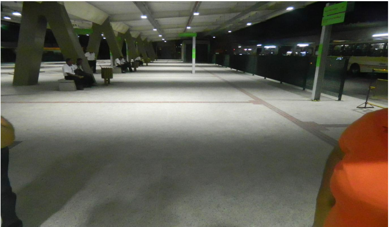
Foto 01 – terminal de Vila Velha, visita feita em 21/01/14 antes da inauguração: nova plataforma já apresentava baixa luminosidade.
