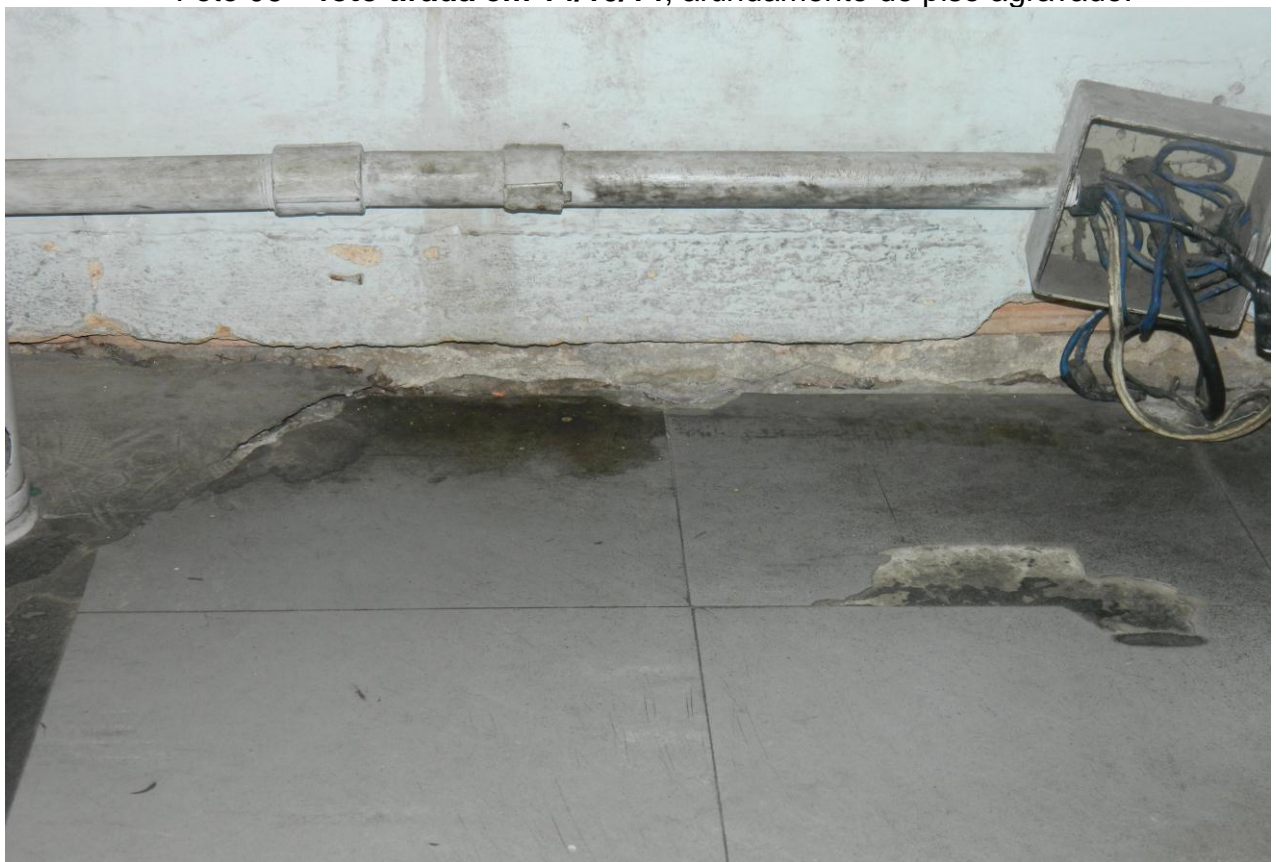
Foto 07 – foto tirada em 14/10/14, agravamento do afundamento de piso na sala dos fiscais da CETURB.
