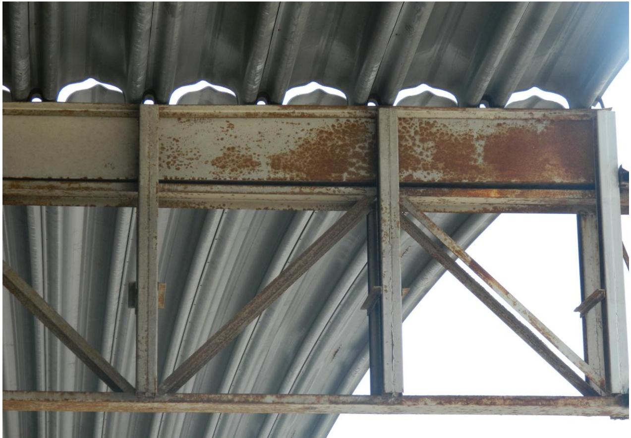
Foto 12 – foto tirada em 14/10/14, afastamento da estrutura metálica.
