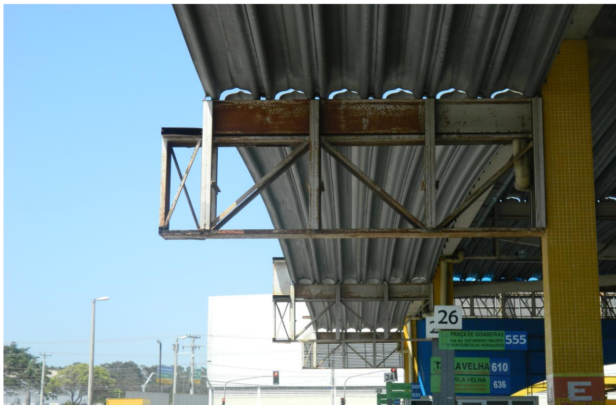
Foto 11 – foto tirada no dia 14/10/14, estrutura metálica corroída pelo tempo.
