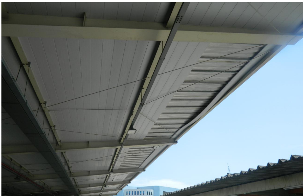
Foto 02 – terminal de Vila Velha, visita feita em 14/10/14 desprendimento de forro de PVC.
