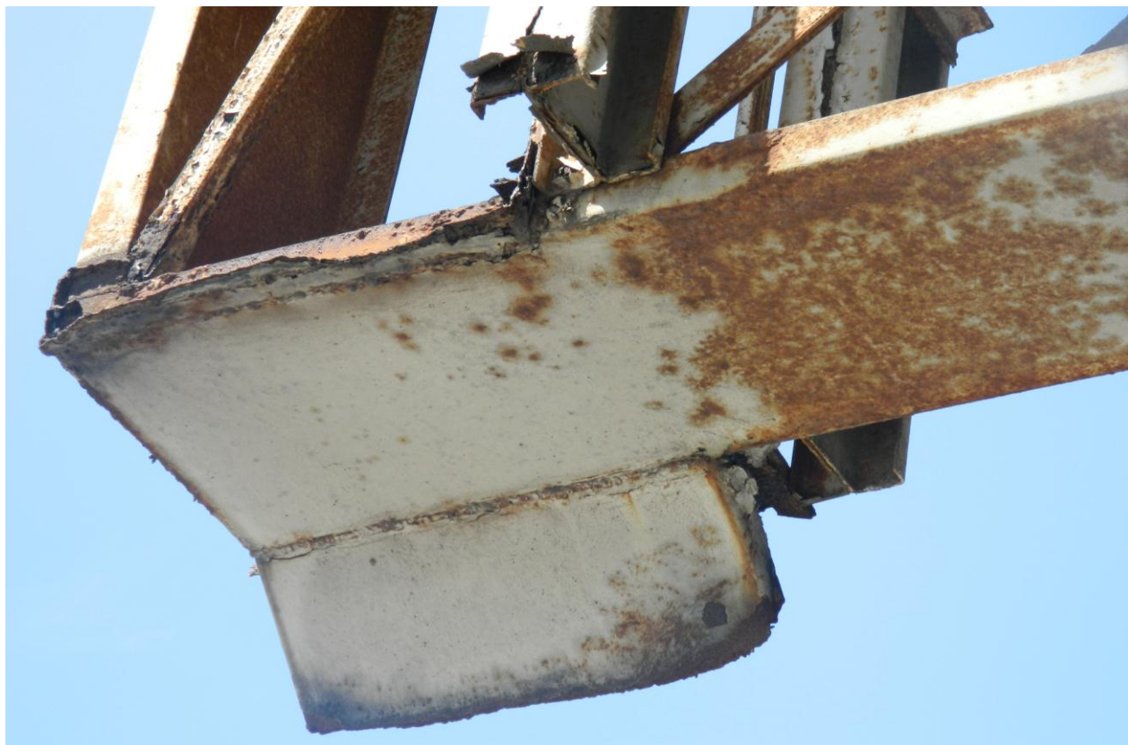
Foto 10 – foto tirada no dia 14/10/14, agravamento da corrosão da estrutura metálica.
