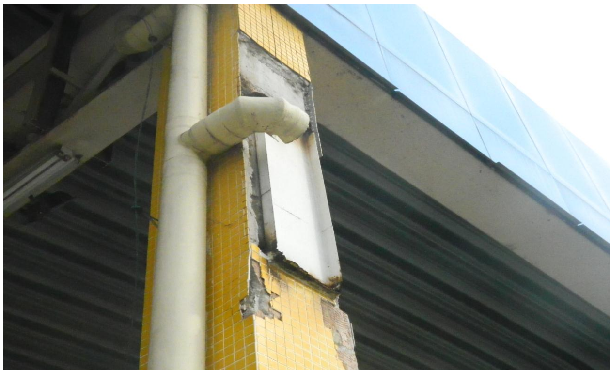
Foto 09 – terminal de Itaparica foto tirada em 21/01/14: estrutura metálica retirada.
