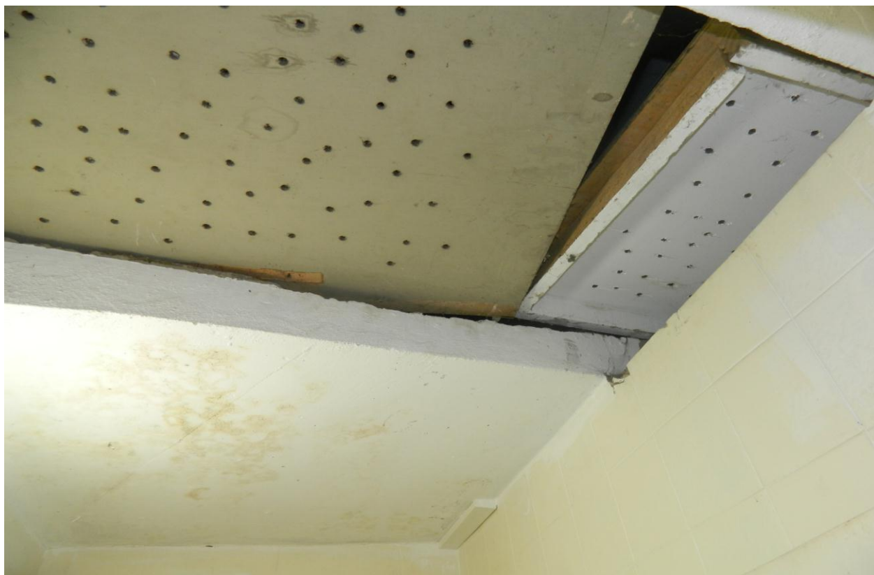
Foto 07 – acesso para o telhado dentro dos banheiros.
