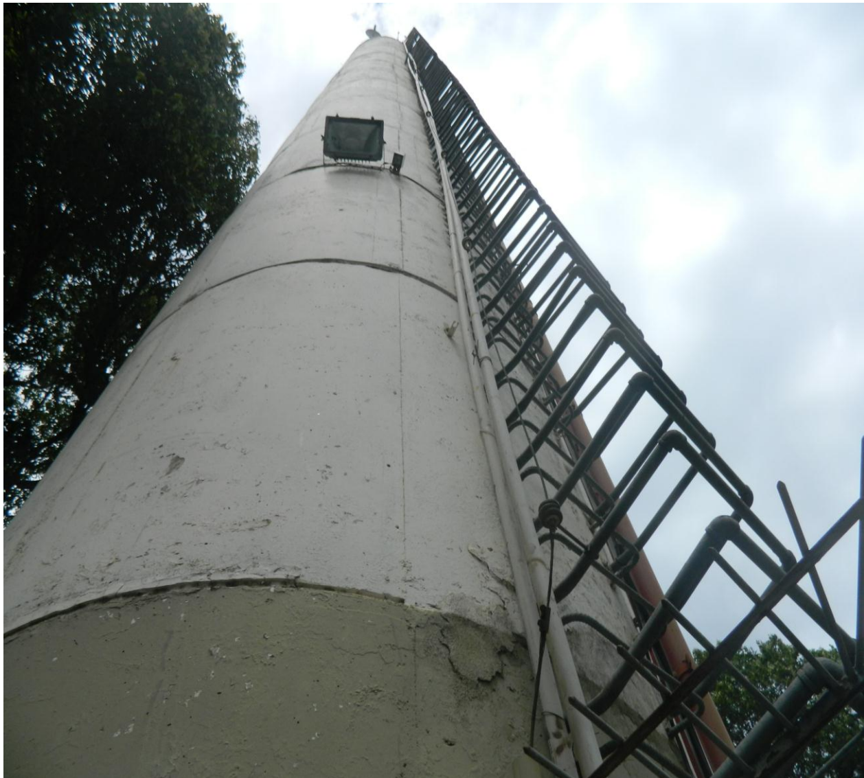
Foto 03 – inexistência de EPI para subida da caixa d'água.
