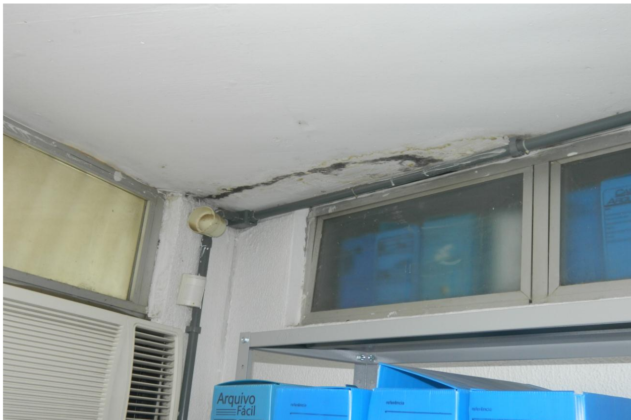
Foto 06- pontos de infiltrações na tesouraria.
