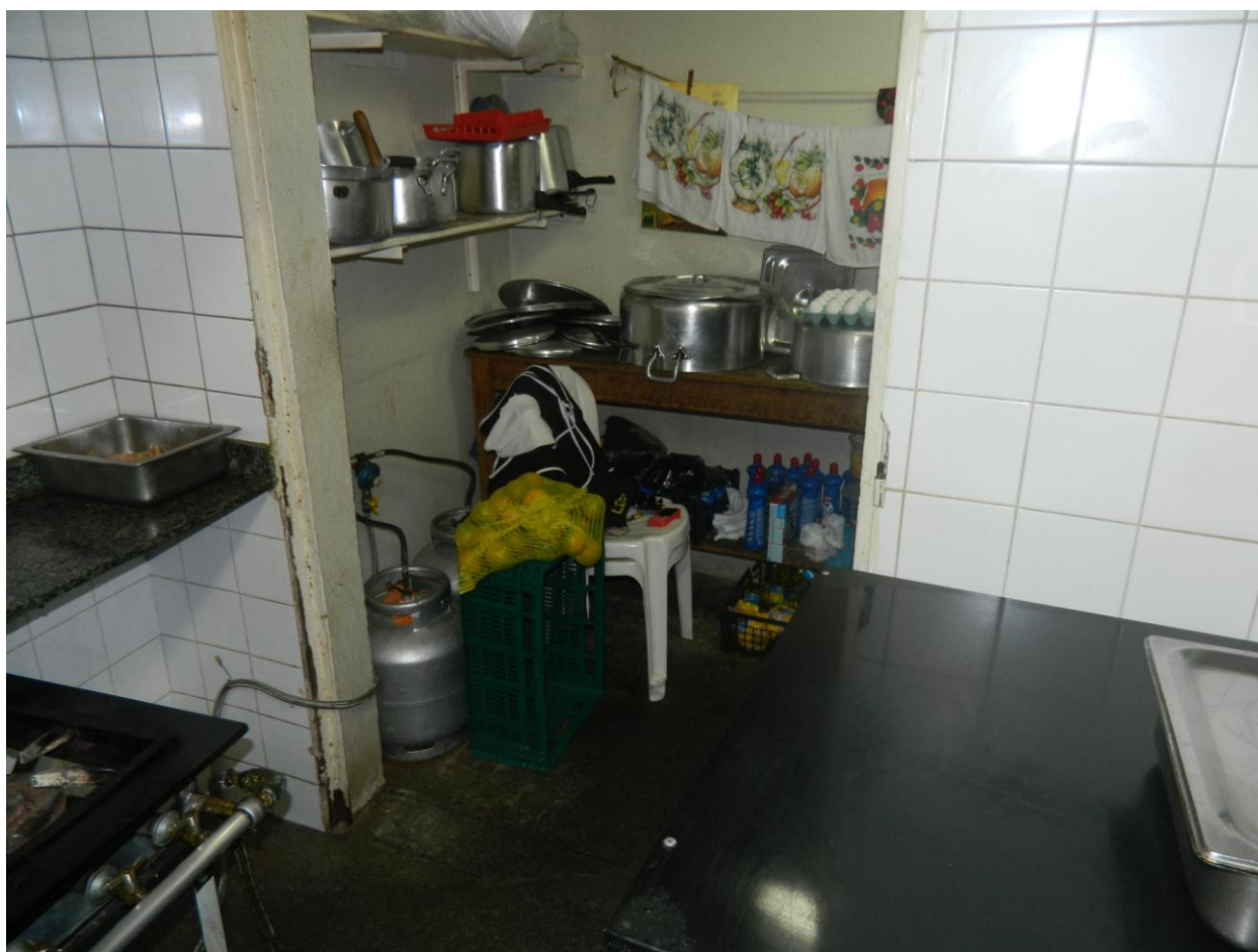
Foto 10 – cozinha do refeitório fora dos padrões sanitários.
