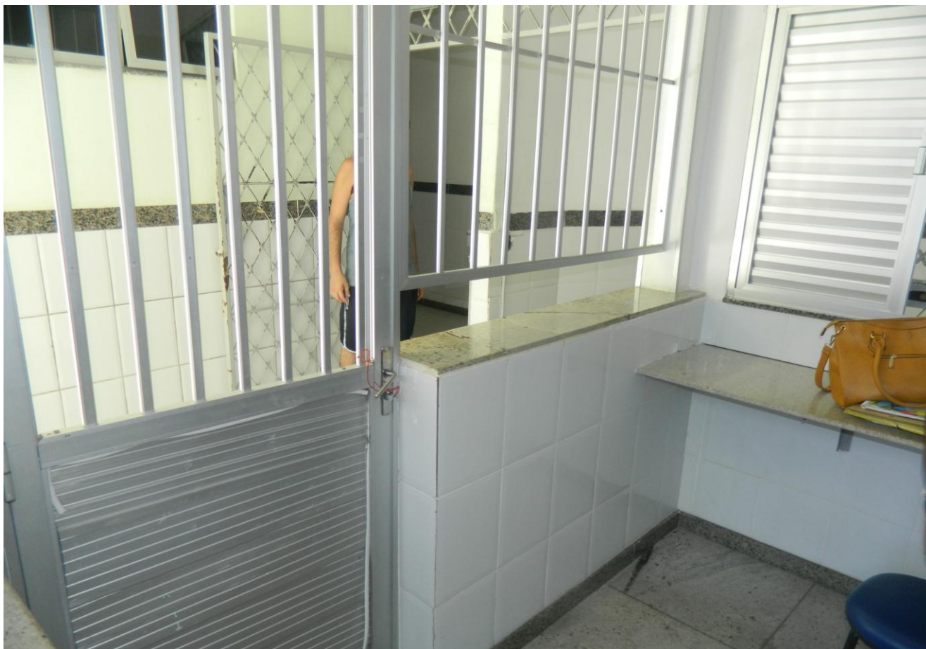
06 – Porta quebrada e calor excessivo na enfermaria.
