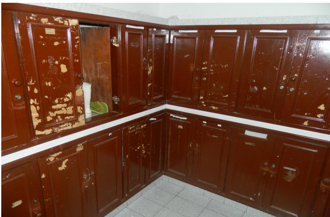
03 – Armários do vestiário cheios de cupins.
