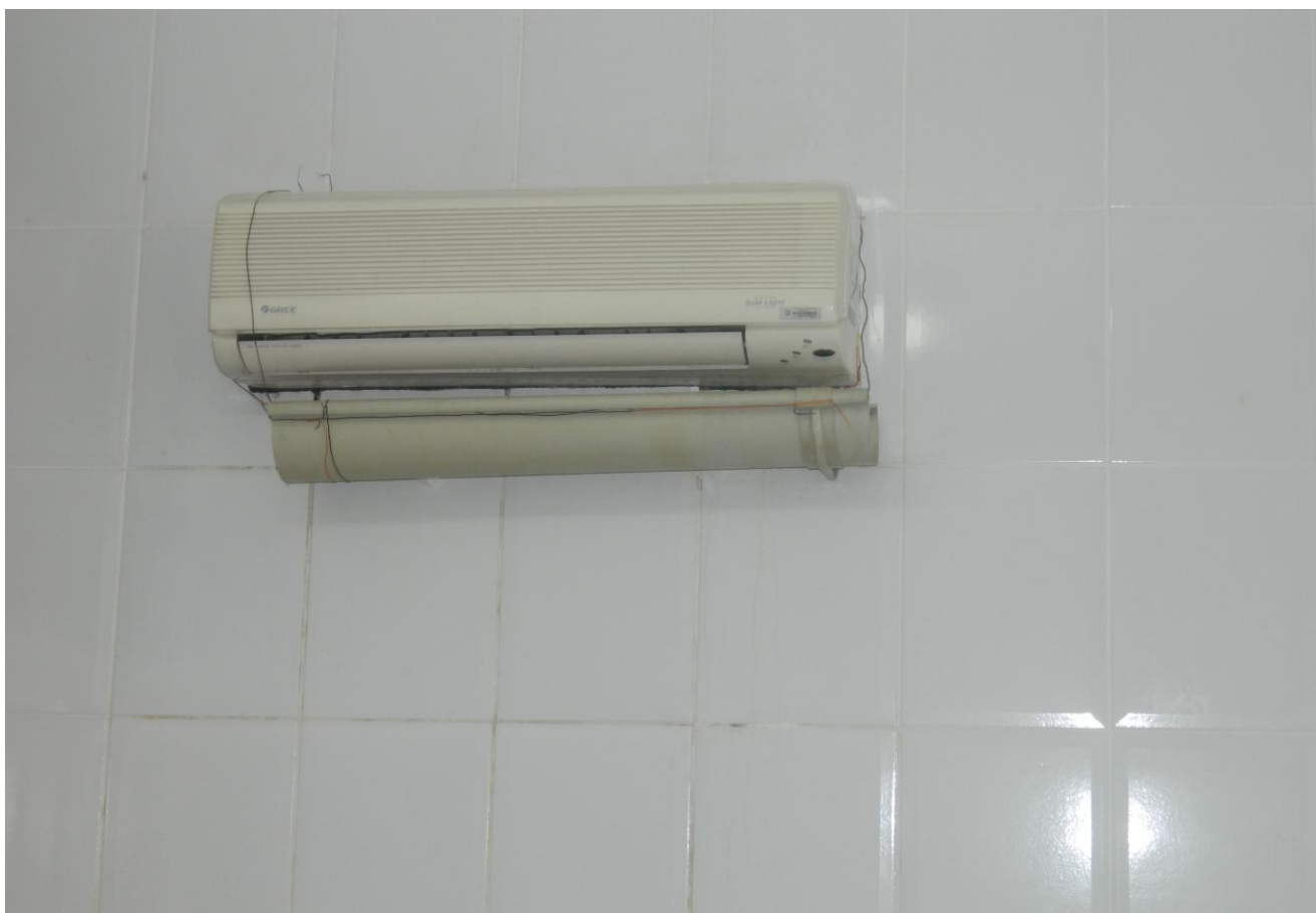
01 – Sala de motorista com ar condicionado quebrado e com calha de chuva.
